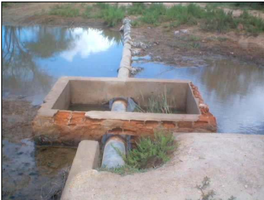
Foto 63 – Travessia Provisória no Riacho Soledade Detalhe das Avarias nas Caixas de Descarga e Registro
