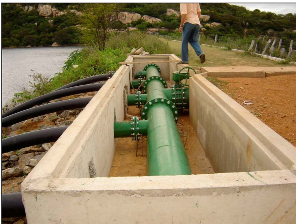
Foto 08 – Caixa de Abrigo do Barrilete de Recalque - Em fase de Implantação
