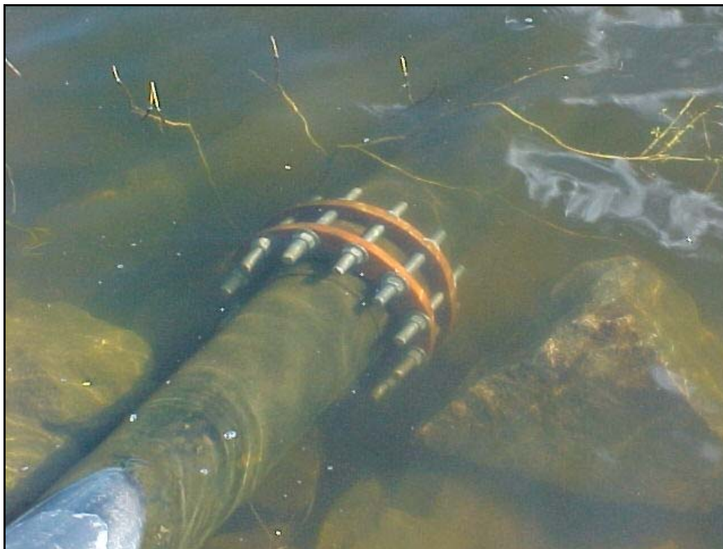
Foto 05 – Flanges Submersos - Enfase Problema Corrosão
