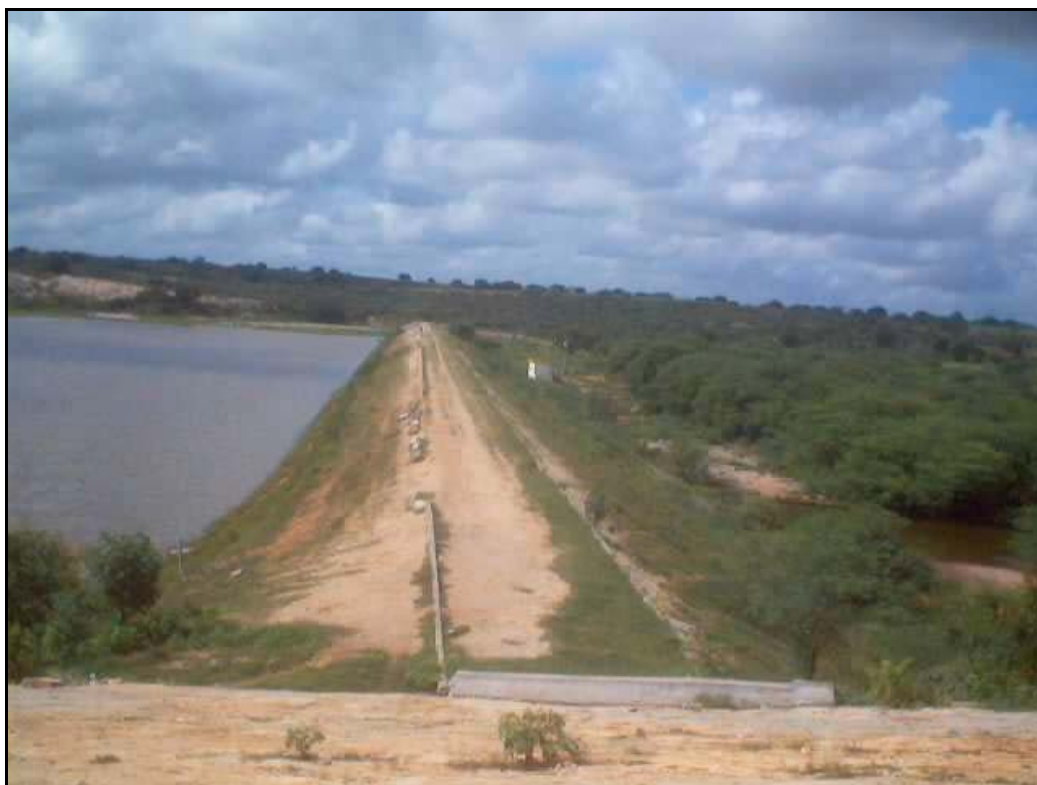
Foto 74 – Açude Olivedos - Erosão no Coroamento e Ombreiras
