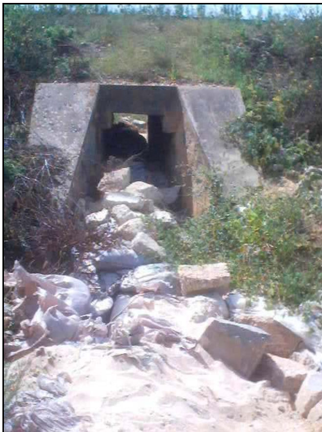
Foto 65 – Travessia Provisória sob Pontilhão da Linha Férrea Blocos de Pedra para Proteger e Firmar o Tubo
