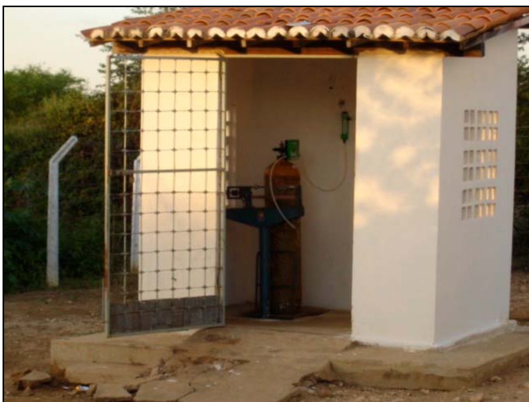
Foto 68 – ETA - Sistema de Cloração - SAA Livramento
