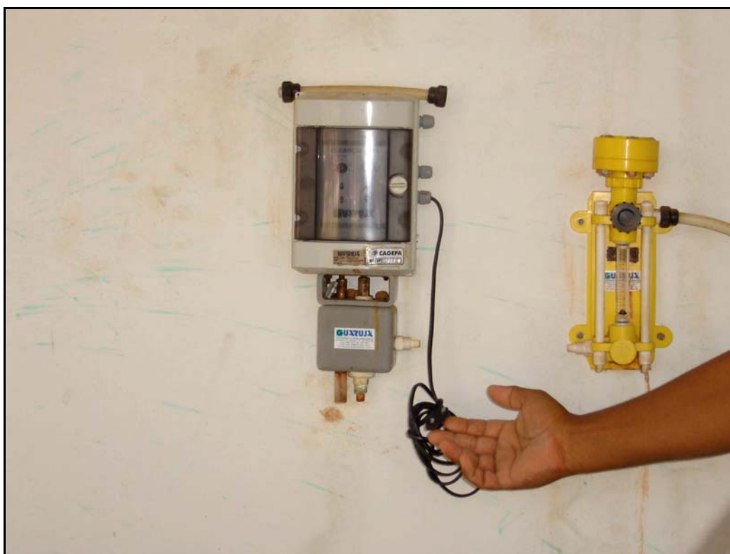
Foto 10 – ETA - Casa de Química - Dosador de Cloro Desligado
