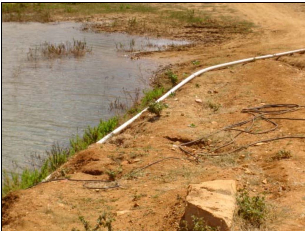
Foto 39 – Linha de Recalque de Água Bruta Provisória
