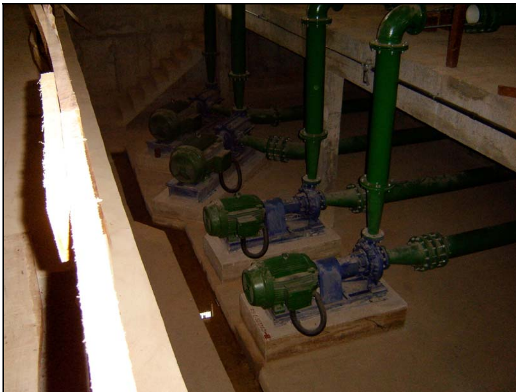
Foto 17 – EB 02 - Conjuntos de Recalque
