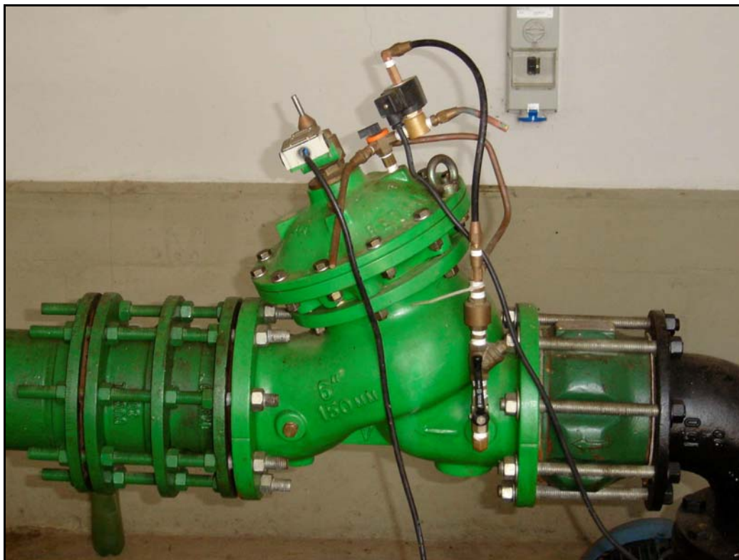
Foto 47 – EE-05 - Detalhe para Válvulas Controladoras de Bomba
