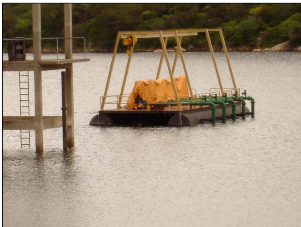
Foto 02 – EB Flutuante - Enfatiza a Falta de Passarela de Acesso
