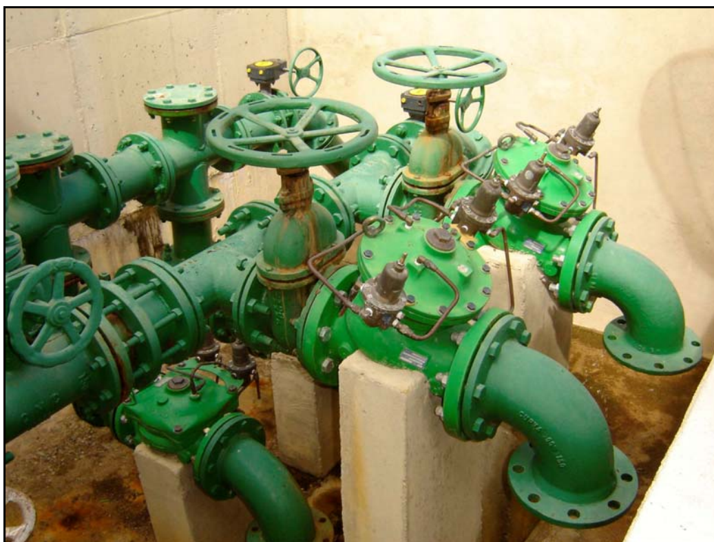
Foto 42 – EE-04 - Caixa de Saída dos Barriletes de Recalque Detalhe para Válvula Antecipadora de Onda
