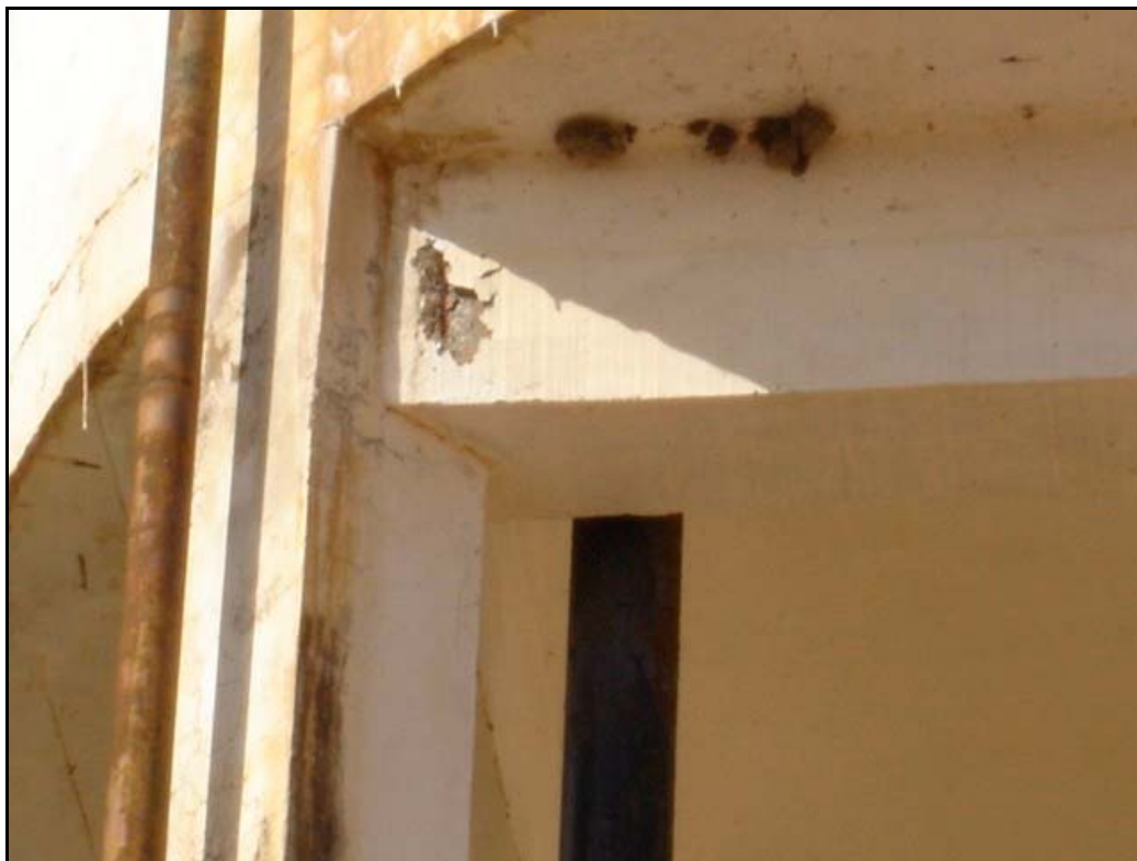
Foto 93 – Reservatório Elevado - Ferragem Exposta - SAA Prata
