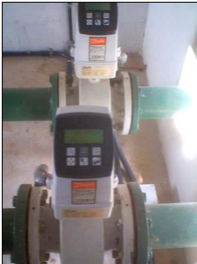
Foto 55 – EE-06 - Detalhes do Medidor de Vazão
