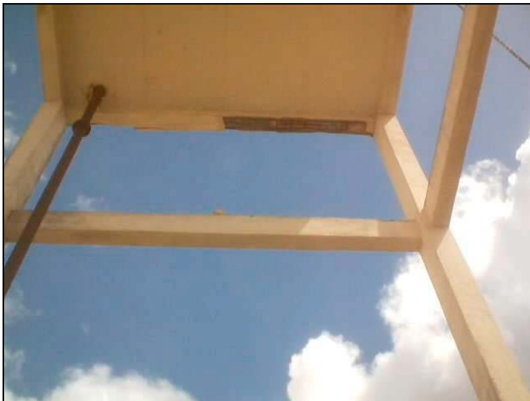
Foto 73 – Reservatório de São Vicente - Detalhe para Ferragem Exposta
