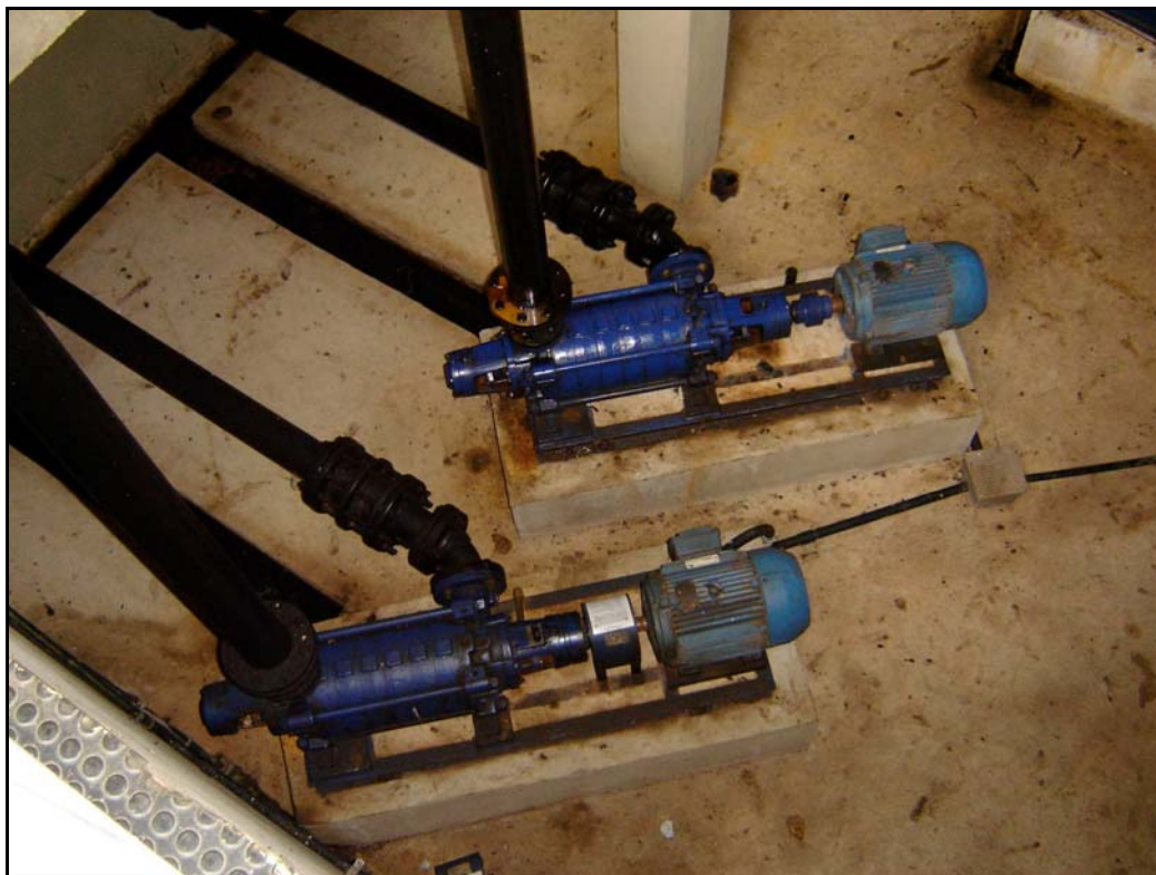
Foto 23 – EE-02 - Conjuntos de Recalque para Cabaceiras - Detalhe para Calhas de Drenagem
