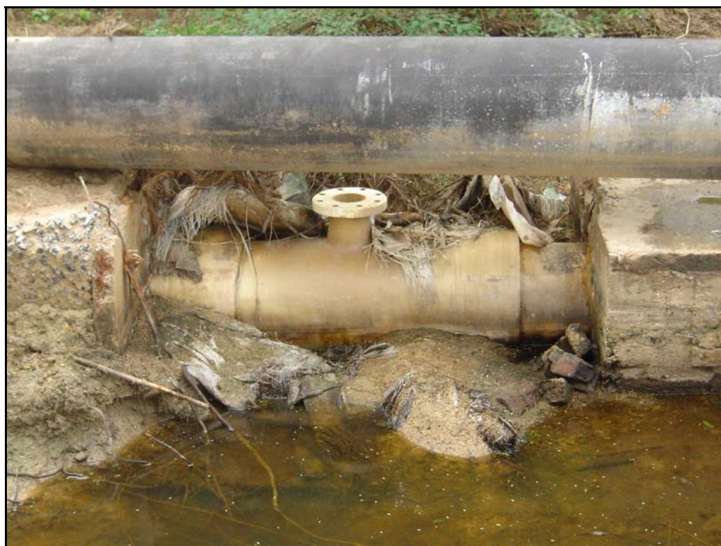
Foto 60 – Travessia Provisória no Riacho Boa Vista Detalhe das Caixas de Descarga e Registro Destruidas
