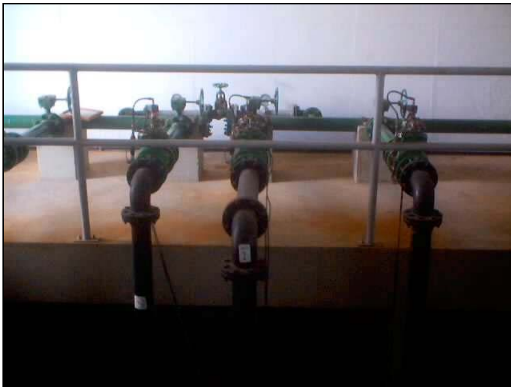
Foto 53 – EE-06 - Barriletes de Recalque
