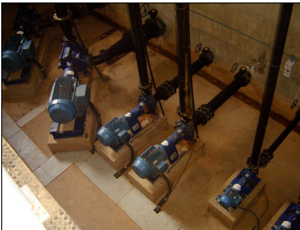
Foto 14 – EE-01 - Conjuntos de Recalque
