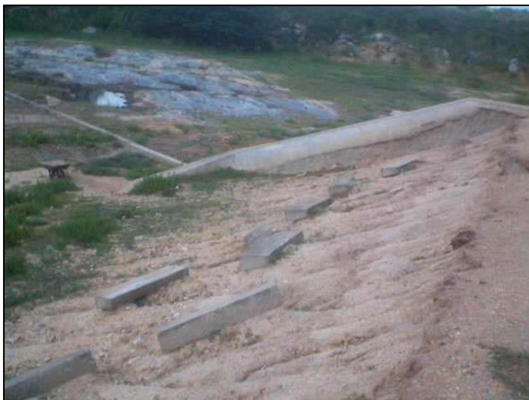
Foto 76 – Açude Olivedos - Erosão no Maciço da Barragem
