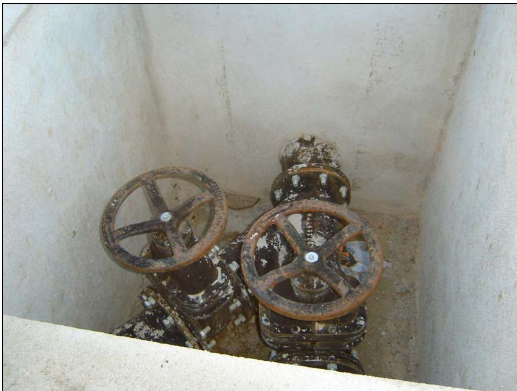
Foto 27 – Interligação do Sistema Existente com o Sistema Adutor do Congo
