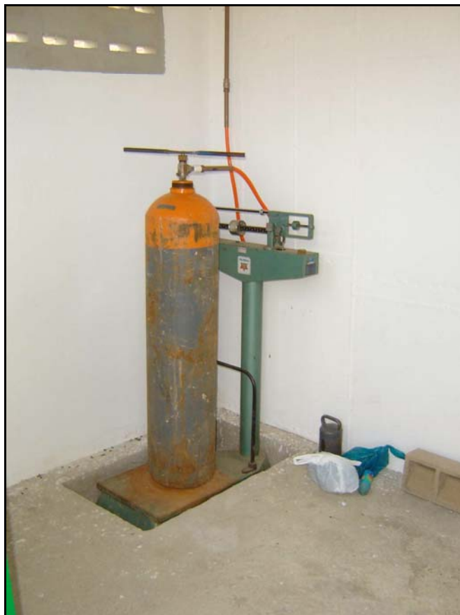
Foto 49 – EE-05 - Equipamentos de Reforço de Cloração
