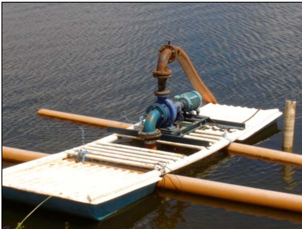
Foto 97 – Barragem São Pedro - Captação Flutuante - SAA Ouro Velho
