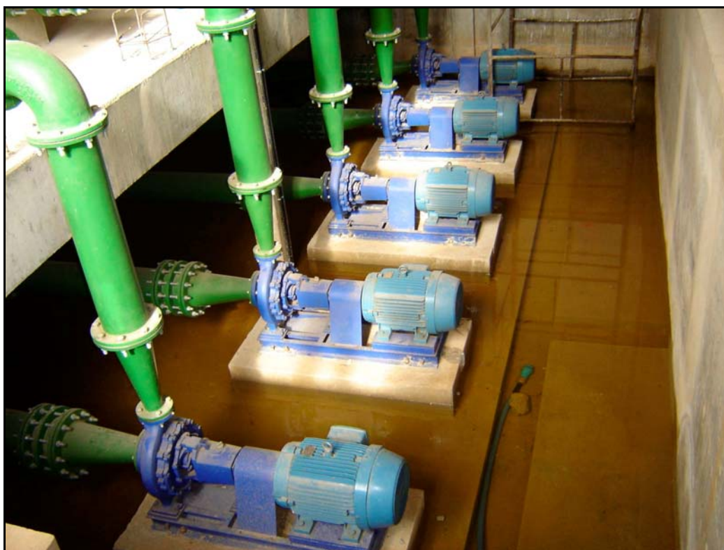
Foto 14 – EB 01 - Enfatiza a Infiltração de Água na Sala de Bombas
