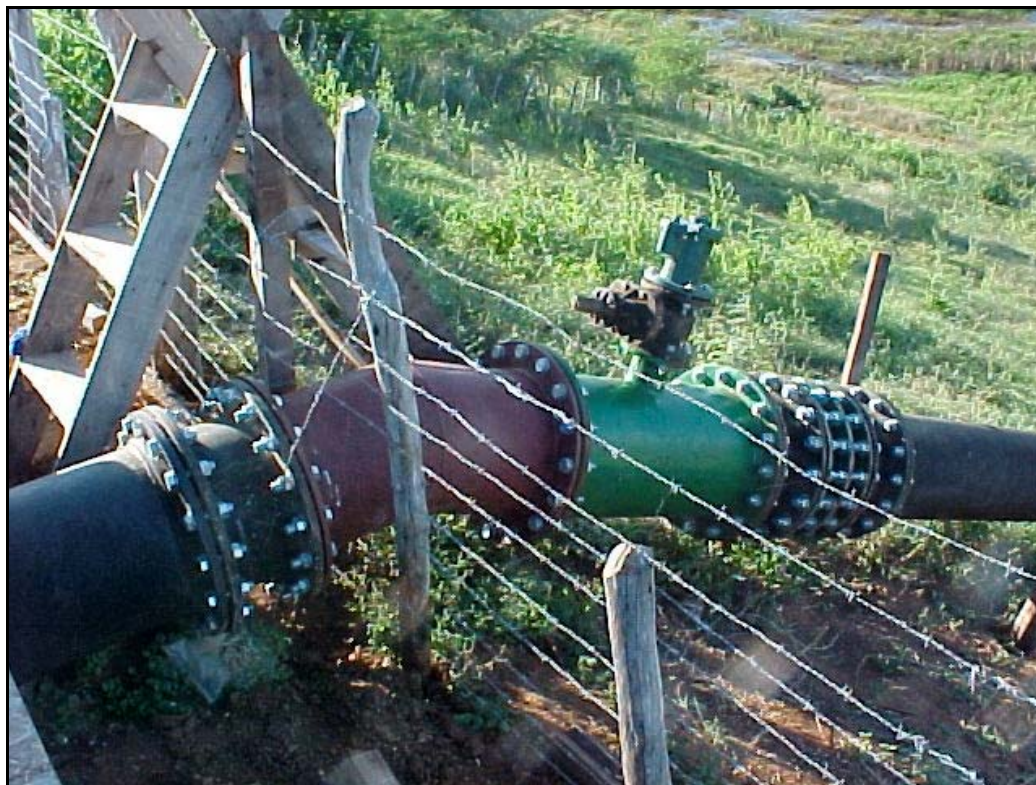
Foto 09 – Interligação Barrilete de Recalque com Adutora de Água Bruta - Ênfase Localização Errada de Ventosa
