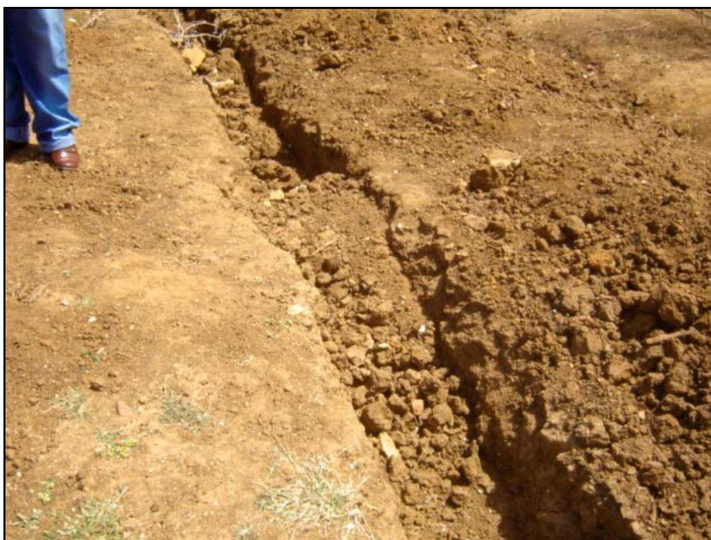
Foto 38 – Vala para Implantação da Nova Tomada d'Água
