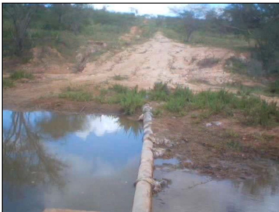
Foto 62 – Travessia Provisória no Riacho Soledade Detalhe dos Sacos de Areia para Proteger e Firmar o Tubo
