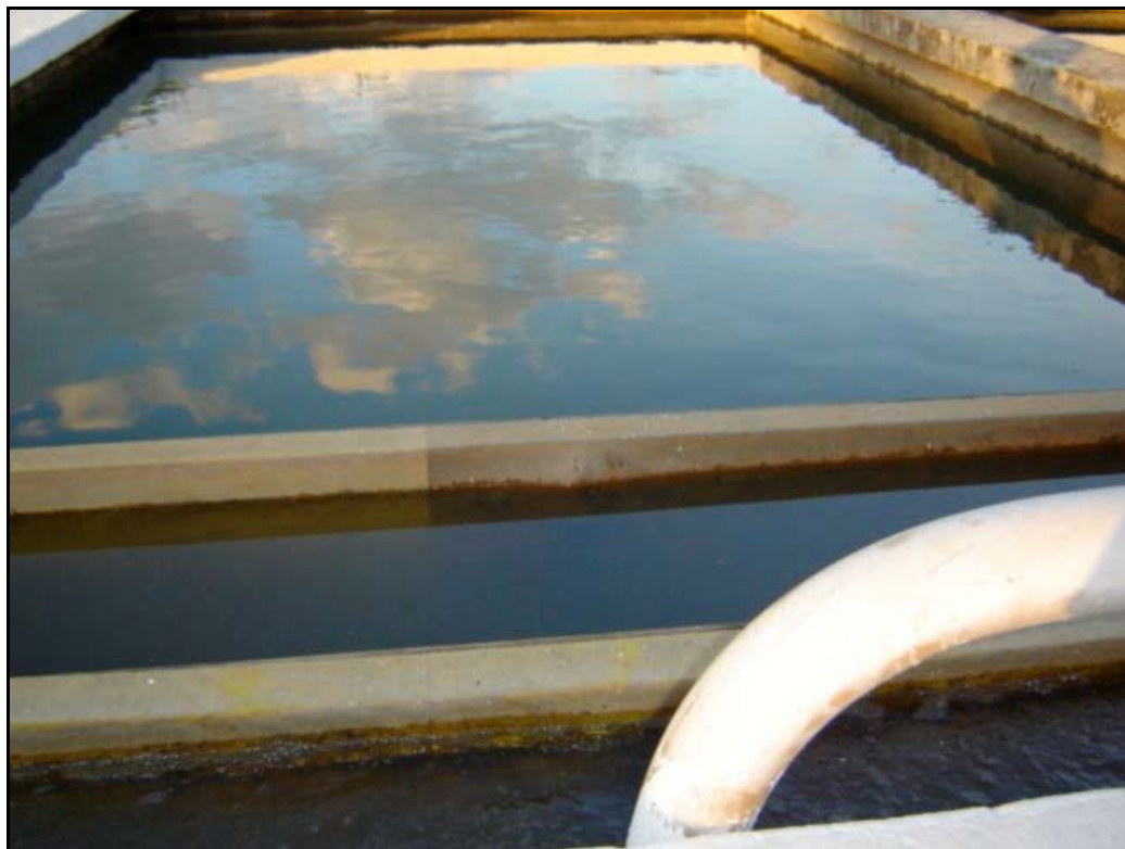
Foto 67 – ETA - Detalhe Canal de Distribuição e Decantador
