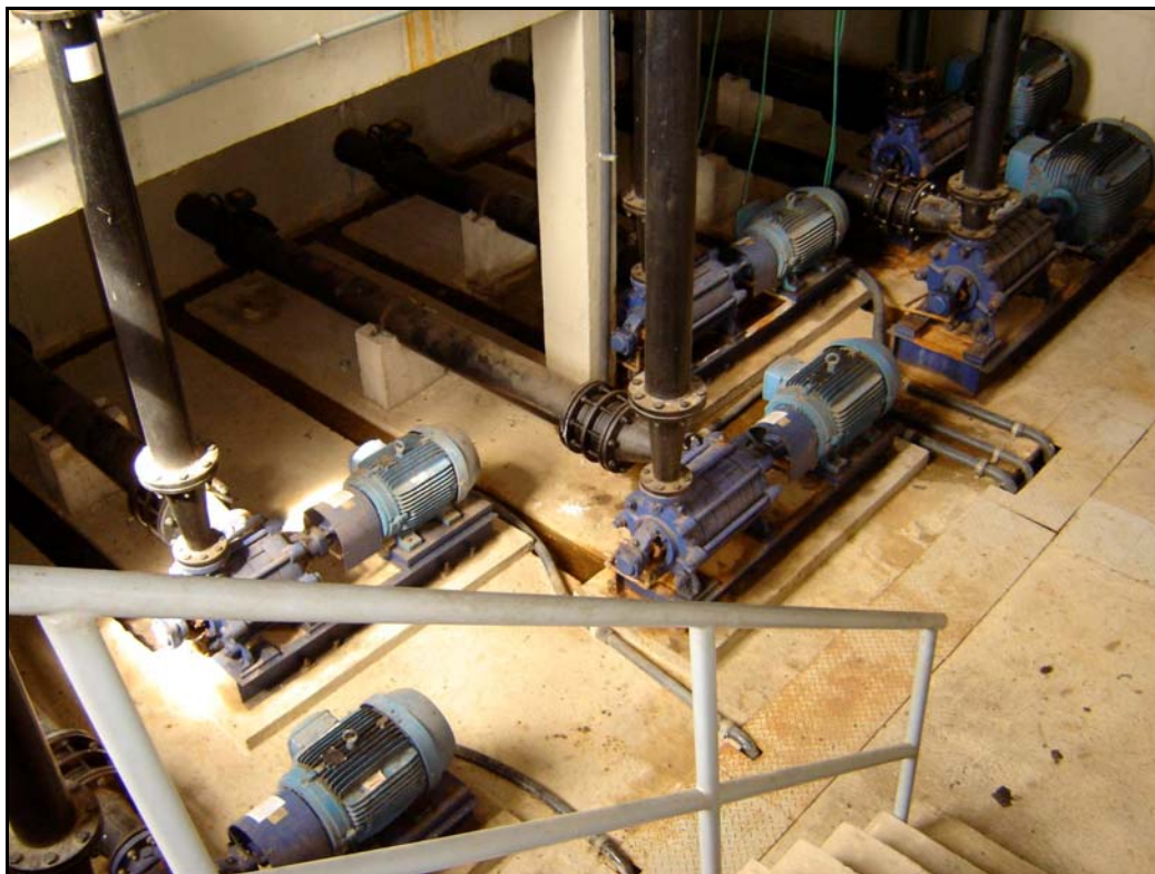
Foto 39 – EE-04 - Conjuntos de Recalque - Detalhe para Calhas de Drenagem
