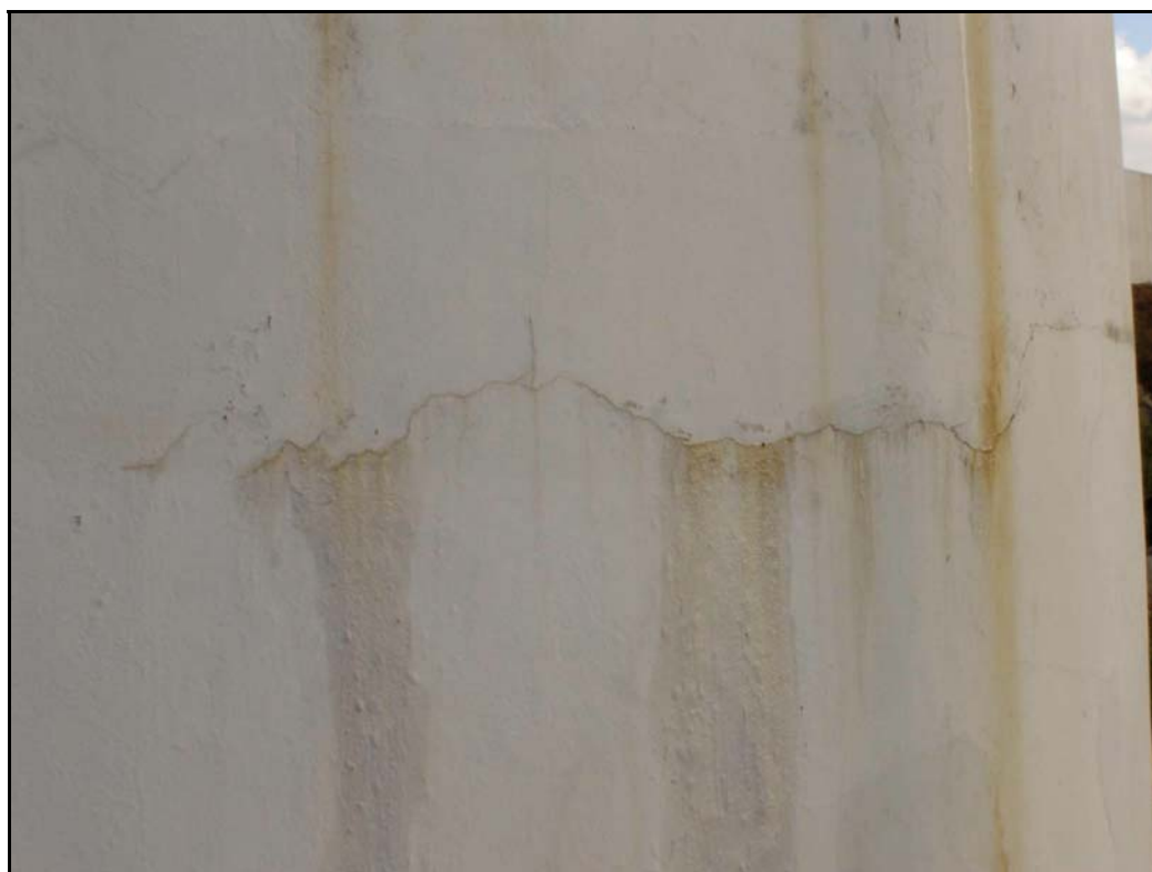
Foto 88 – Detalhe da Fissura no Reservatório
