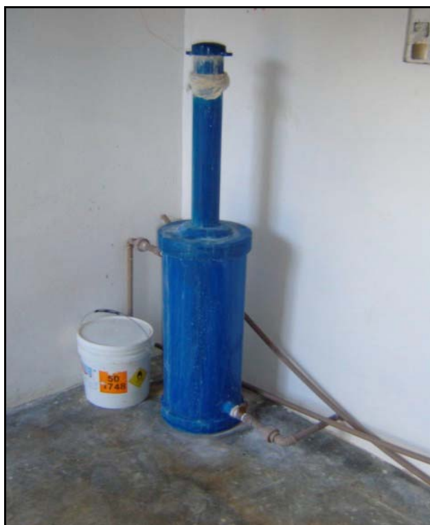
Foto 78 – ETA - Clorador de Pastilha - SAA Coxixola
