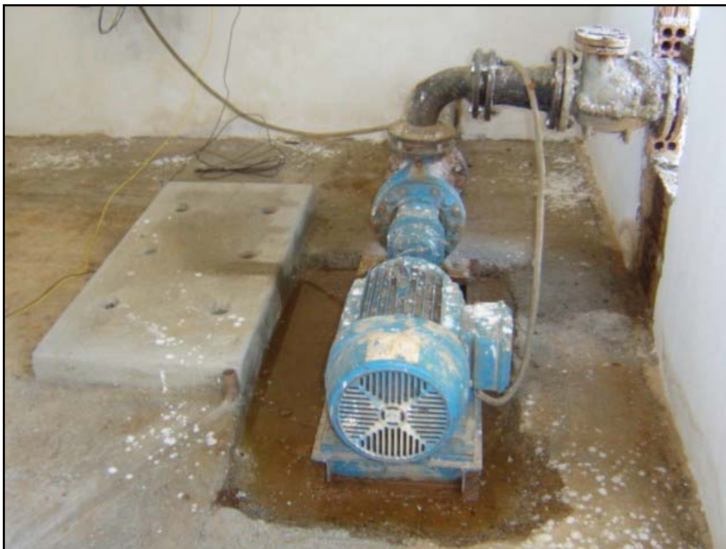
Foto 99 – Estação Elevatória de Água Bruta - Conjunto Elevatório Antigo - SAA Ouro Velho
