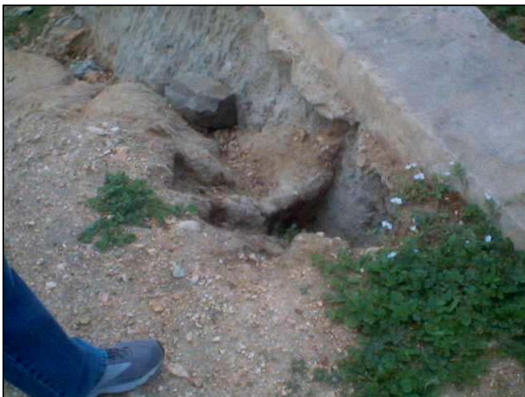
Foto 78 – Açude Olivados - Erosão na Ombreira da Barragem
