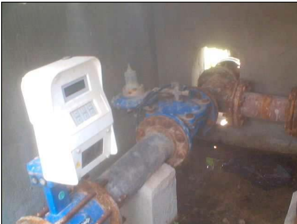
Foto 71 – Barrilete de Entrada - Reservatório de São Vicente Detalhe do Medidor de Pressão e Válvula de Nível
