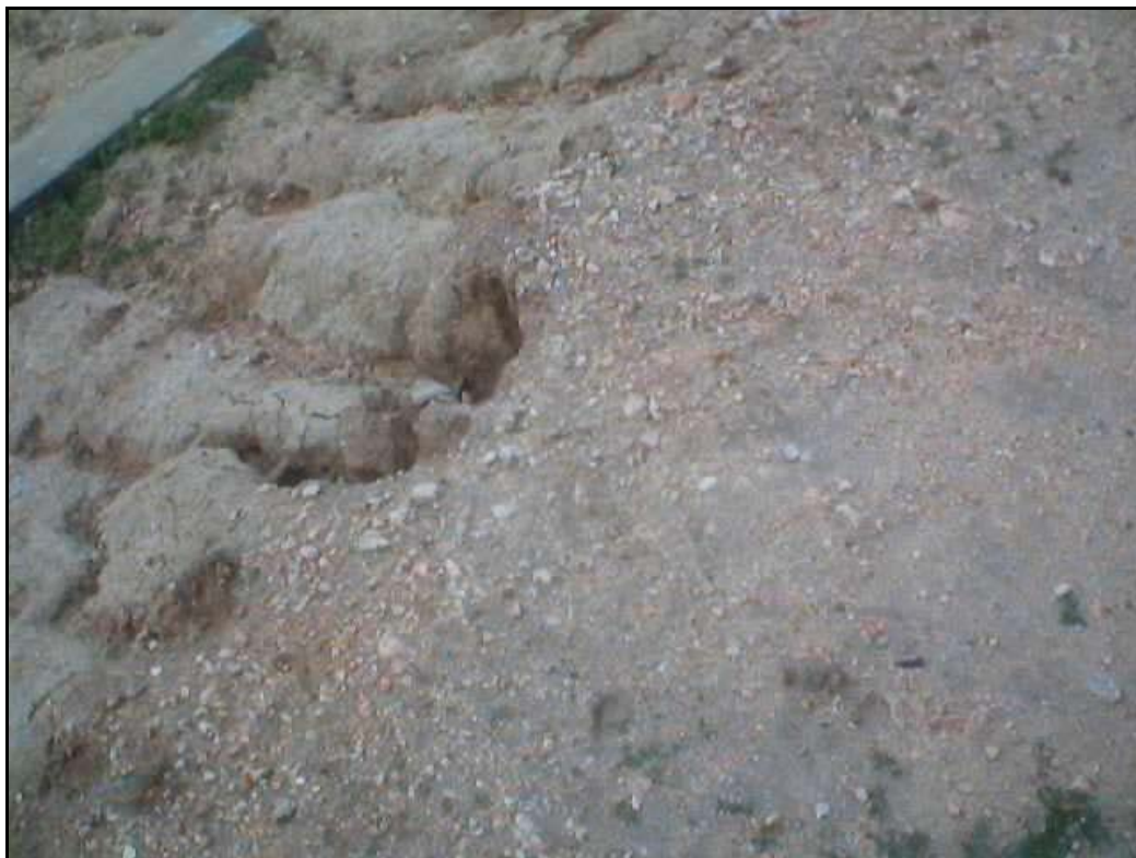
Foto 77 – Açude Olivados - Erosão no Coroamento da Barragem
