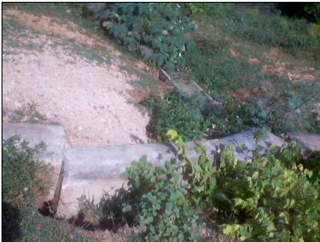
Foto 75 – Açude Olivedos - Calha Vertedora Quebrada
