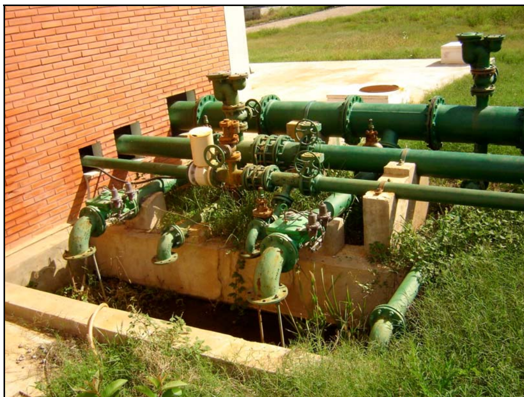
Foto 18 – EE-01 - Caixa de Saída dos Barriletes de Recalque Detalhe para Válvula Antecipadora de Onda
