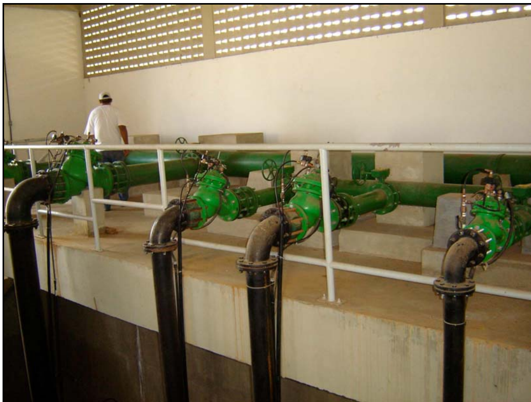
Foto 15 – EE-01 - Barriletes de Recalque com Válvulas Controladoras de Bomba
