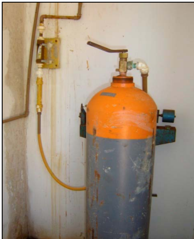
Foto 105 – Sistema de Cloração - SAA Ouro Velho
