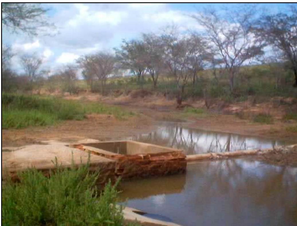
Foto 64 – Travessia Provisória no Riacho Soledade Detalhe das Avarias nas Caixas de Descarga e Registro
