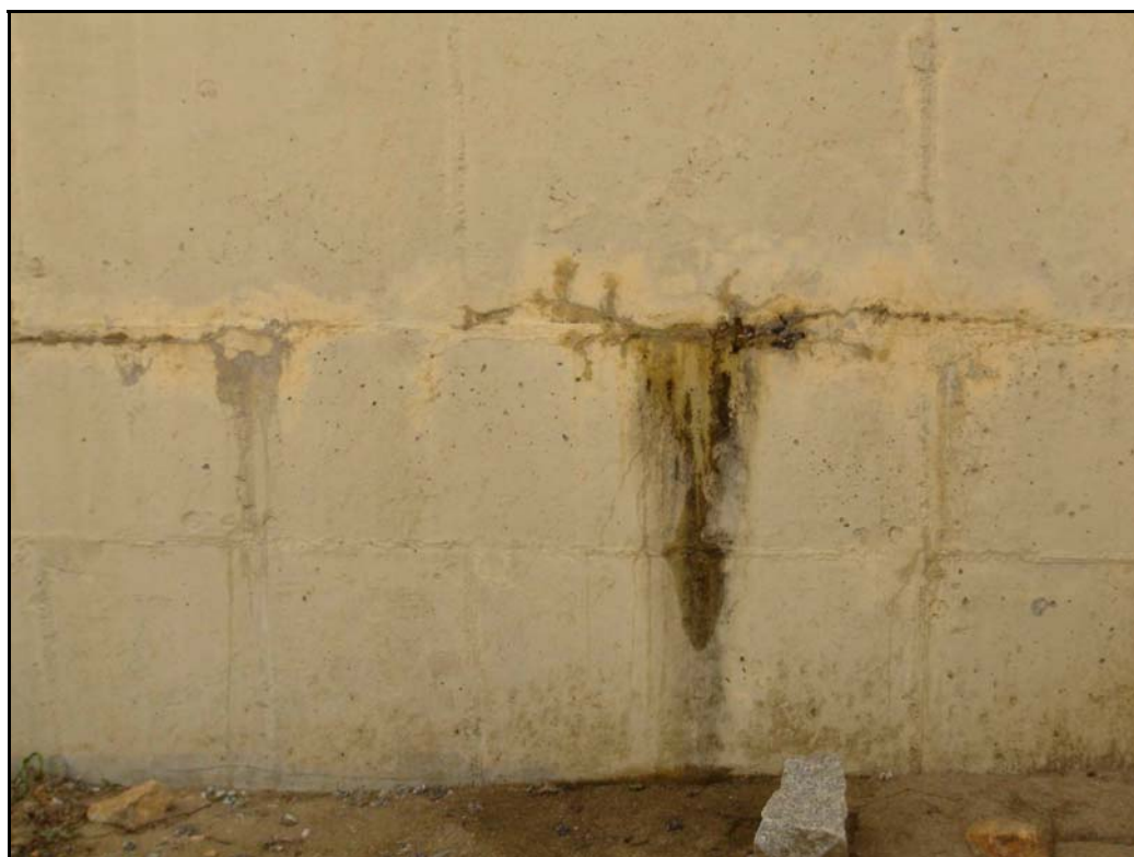
Foto 44 – EE-04 - Fissuras no Tanque de Sucção
