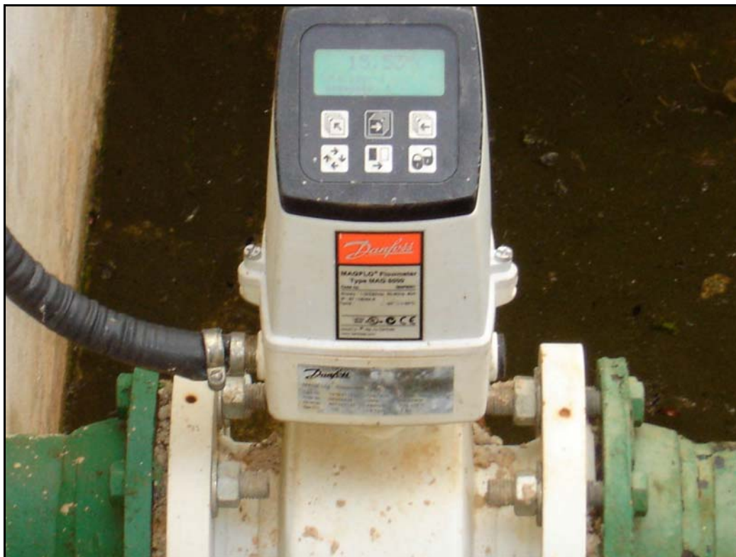
Foto 25 – EE-02 - Detalhe Medidor de Vazão
