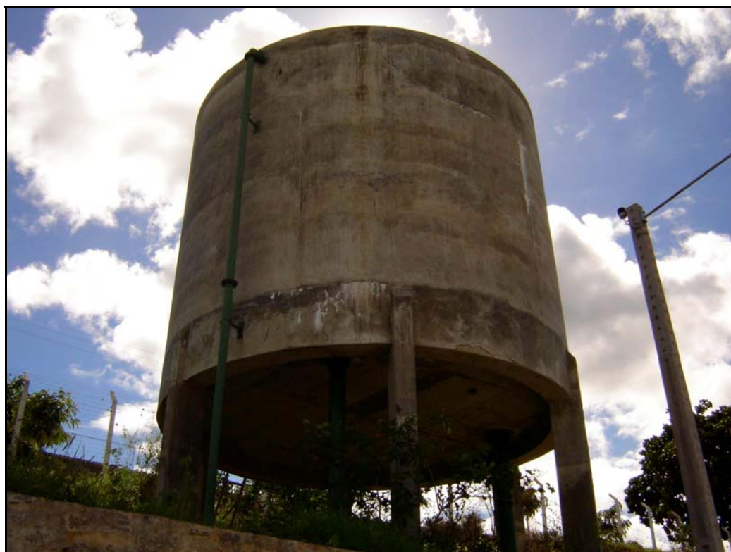
Foto 12 – ETA - Reservatório de Lavagem dos Filtros
