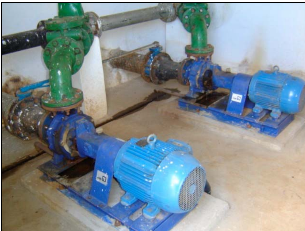
Foto 75 – Estação Elevatória de Água Bruta - Conjuntos de Recalque - SAA Coxixola
