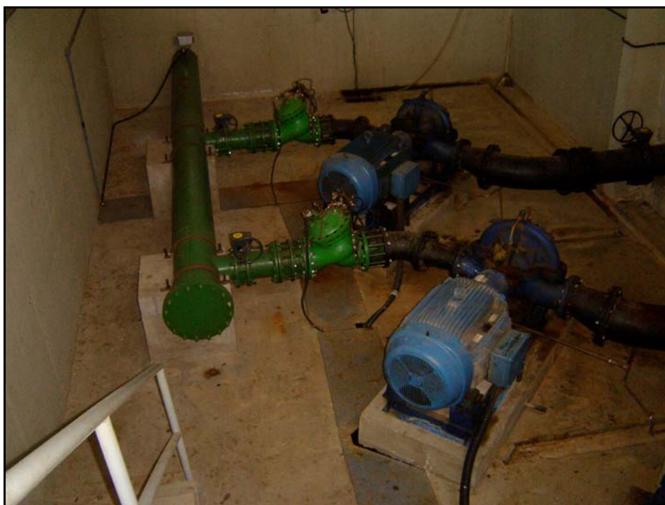
Foto 30 – EE-03 - Conjuntos de Recalque para EE-04 com Válvulas Controladoras de Bomba
