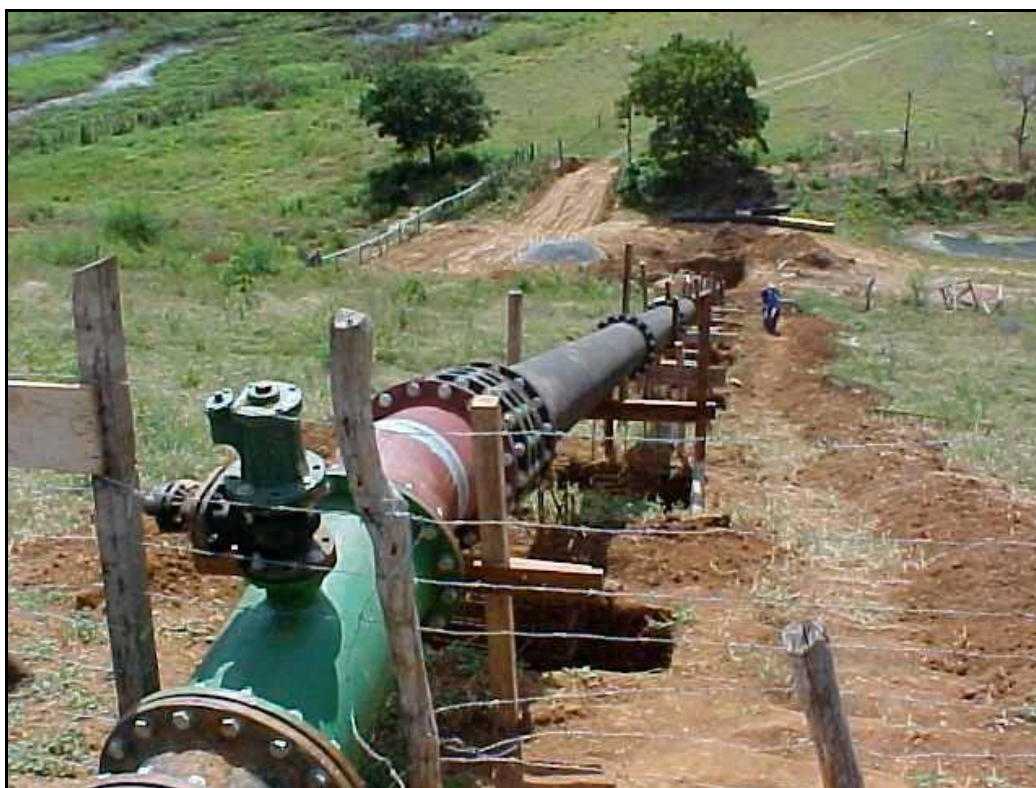
Foto 10 – Interligação Barrilete de Recalque com Adutora de Água Bruta - Ênfase Localização Errada de Ventosa
