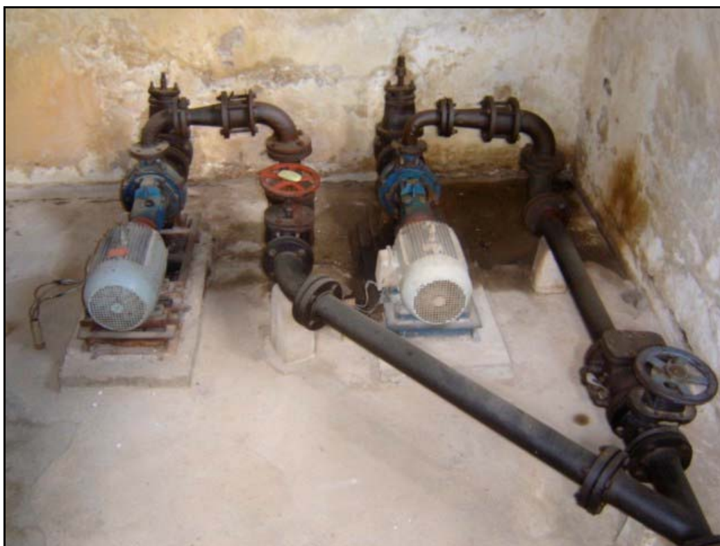
Foto 88 – Estação Elevatória de Água Bruta - Conjuntos Elevatórios - SAA Prata
