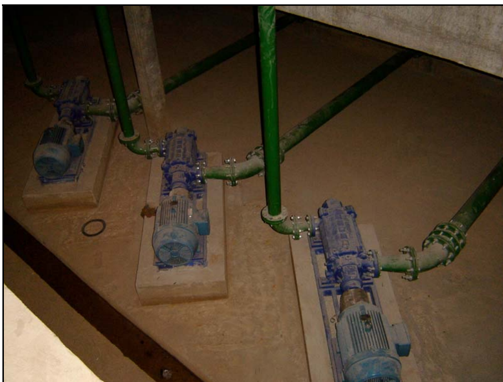
Foto 16 – EB 02 - Conjuntos de Recalque
