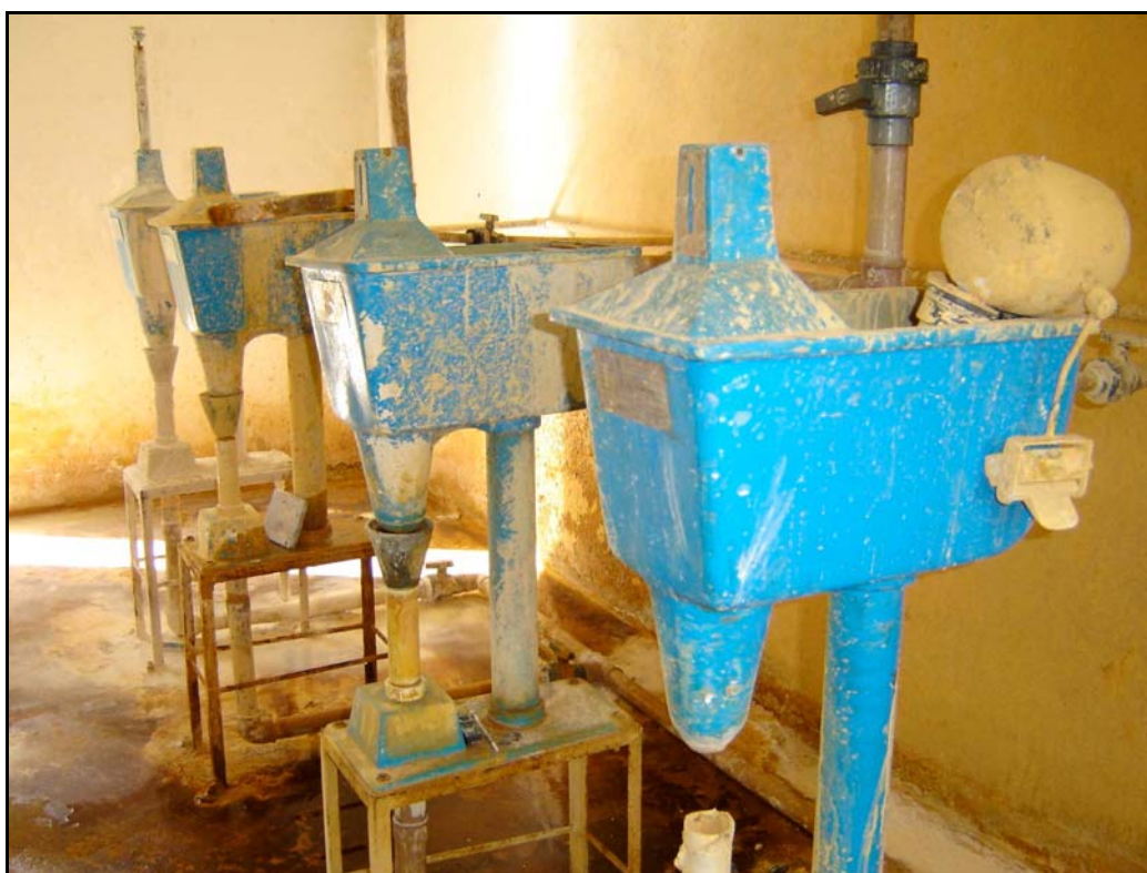
Foto 08 – ETA - Casa de Química - Dosadores de Sulfato
