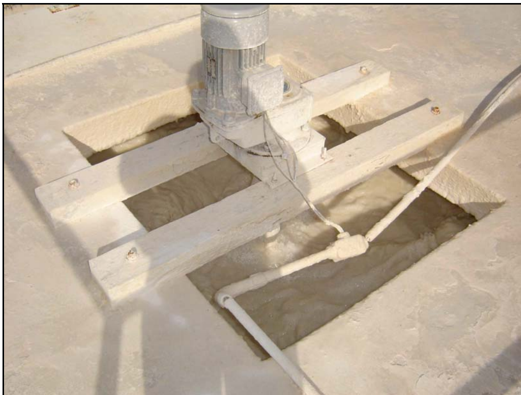
Foto 09 – ETA - Casa de Química - Tanque e Misturador de Cal
