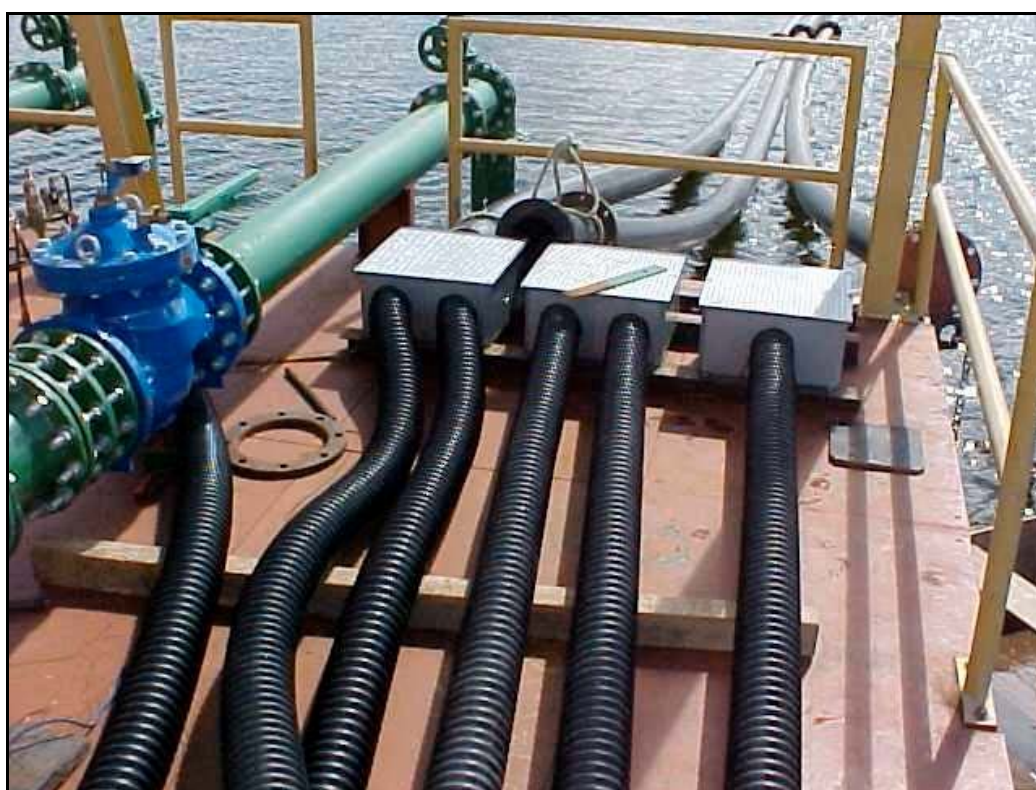
Foto 04 – EB Flutuante - Montagem Tubos PEAD e Cabos Elétricos
