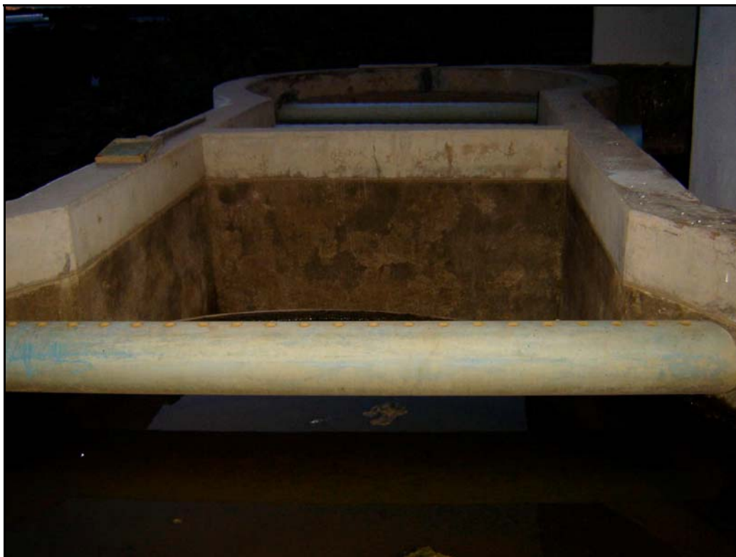
Foto 93 – Filtro Ascendente Desativado
