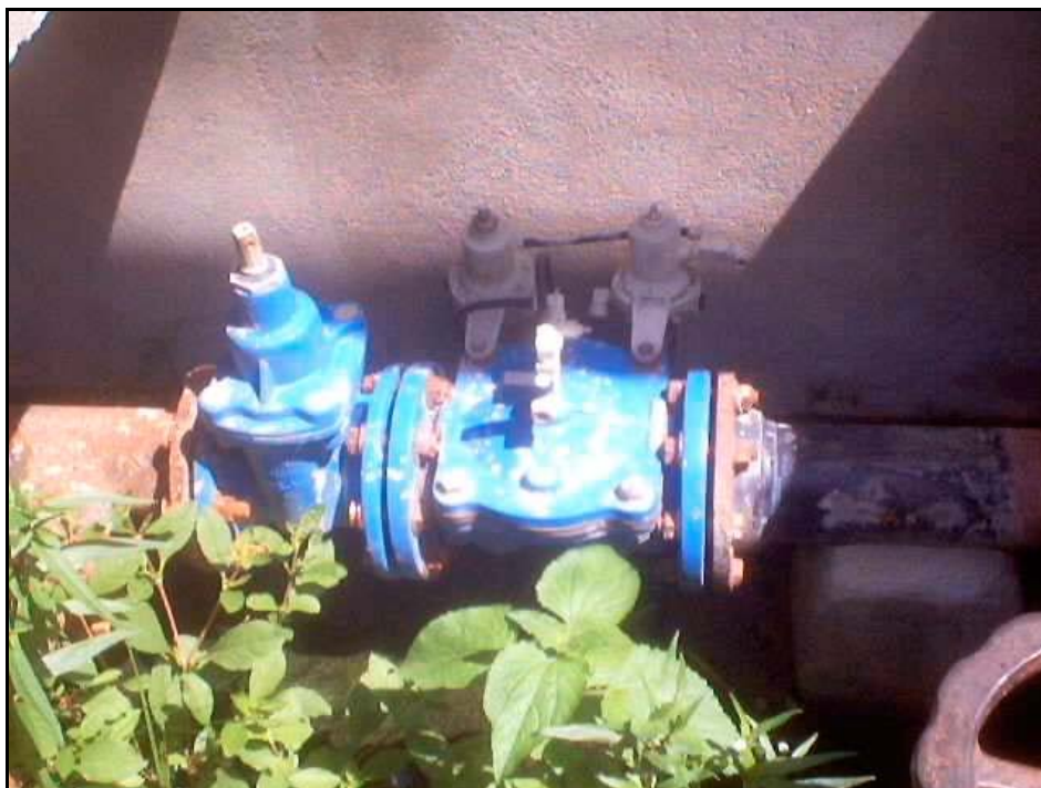
Foto 70 – Barrilete de Entrada - Reservatório de São Vicente Detalhe da Válvula Controladora de Vazão que Não Funciona
