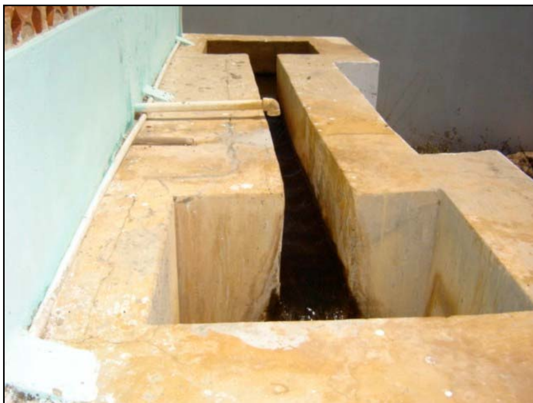
Foto 102 – Detalhe do Canal de Chegada de Água Bruta - SAA Ouro Velho
