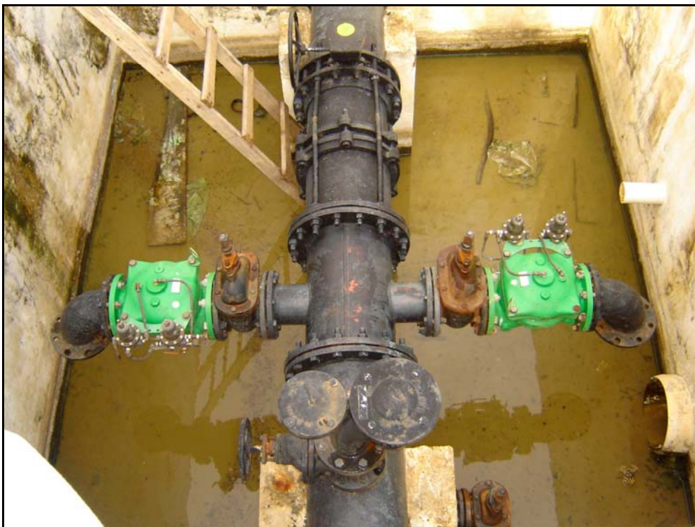
Foto 37 – EE-03 - Caixa de Saída dos Barriletes de Recalque Detalhe para Válvula Antecipadora de Onda
