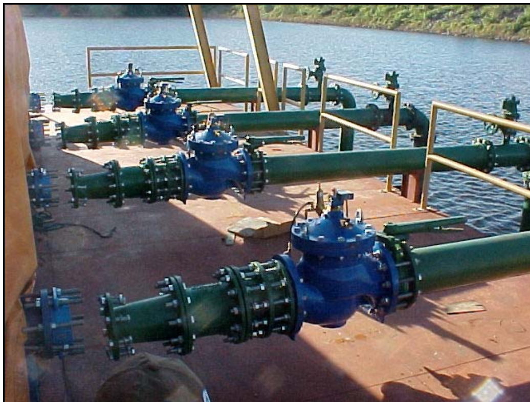
Foto 03 – EB Flutuante - Detalhe das Válvulas
