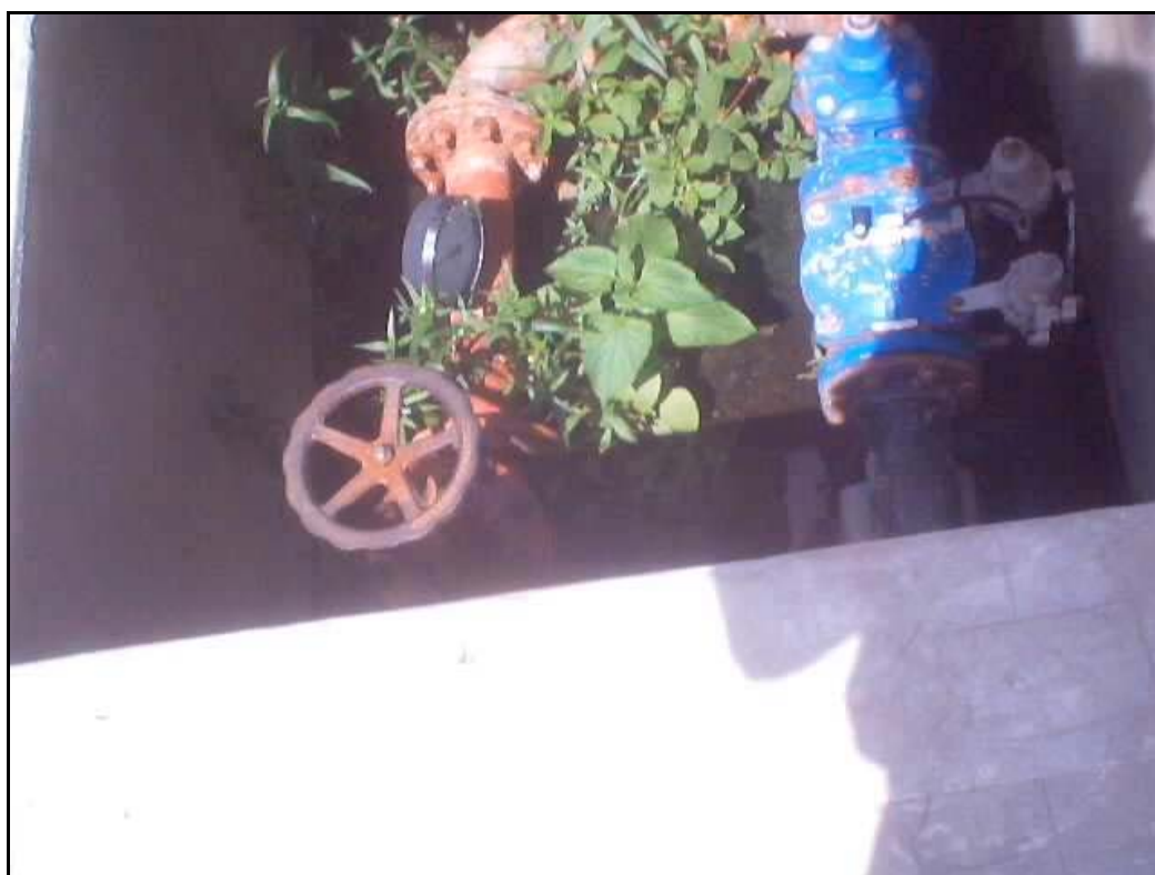
Foto 72 – Barrilete de Entrada - Reservatório de São Vicente Detalhe do “by pass” com Registro e Entrada com Válvula Controladora de Vazão
