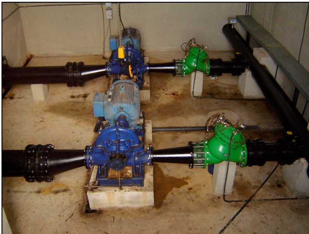
Foto 22 – EE-02 - Conjuntos de Recalque para EE-03 com Válvulas Controladoras de Bomba
