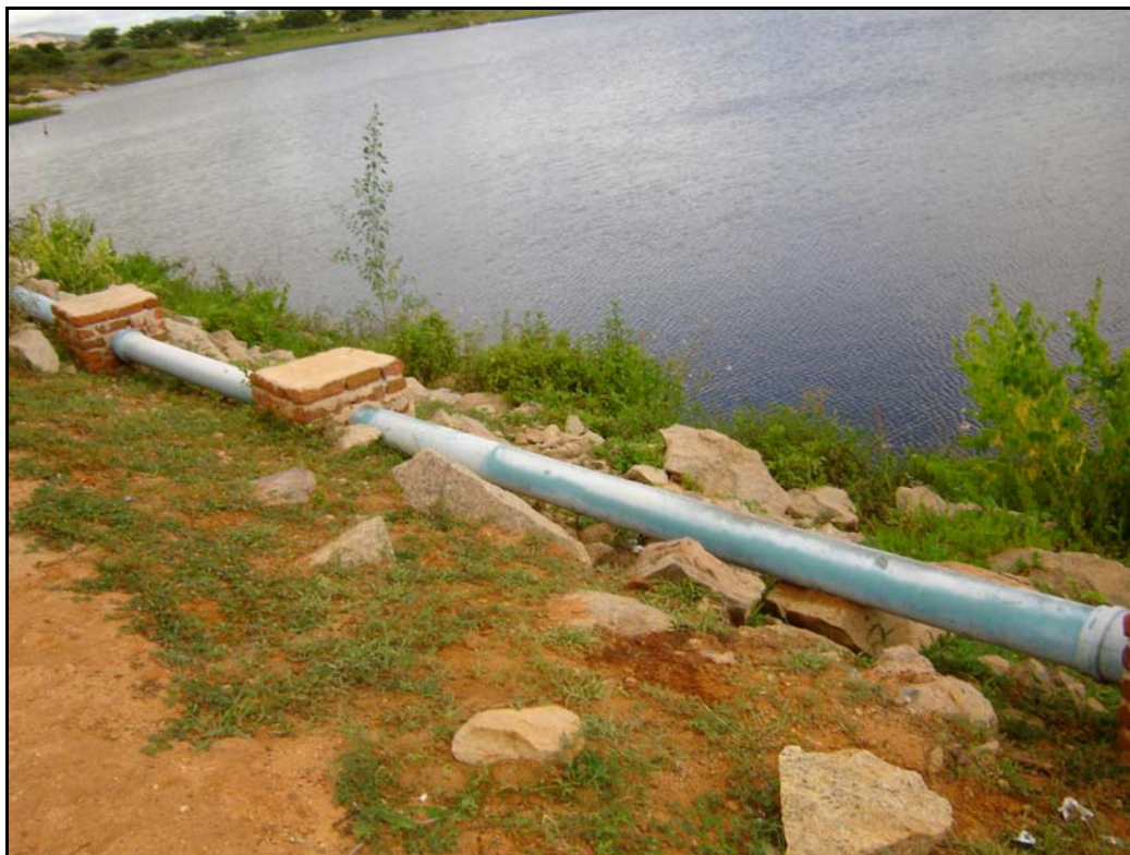
Foto 29 – Adutora da Barragem Serra Branca 1 - Enfatiza a Forma Inadequada de Implantação
