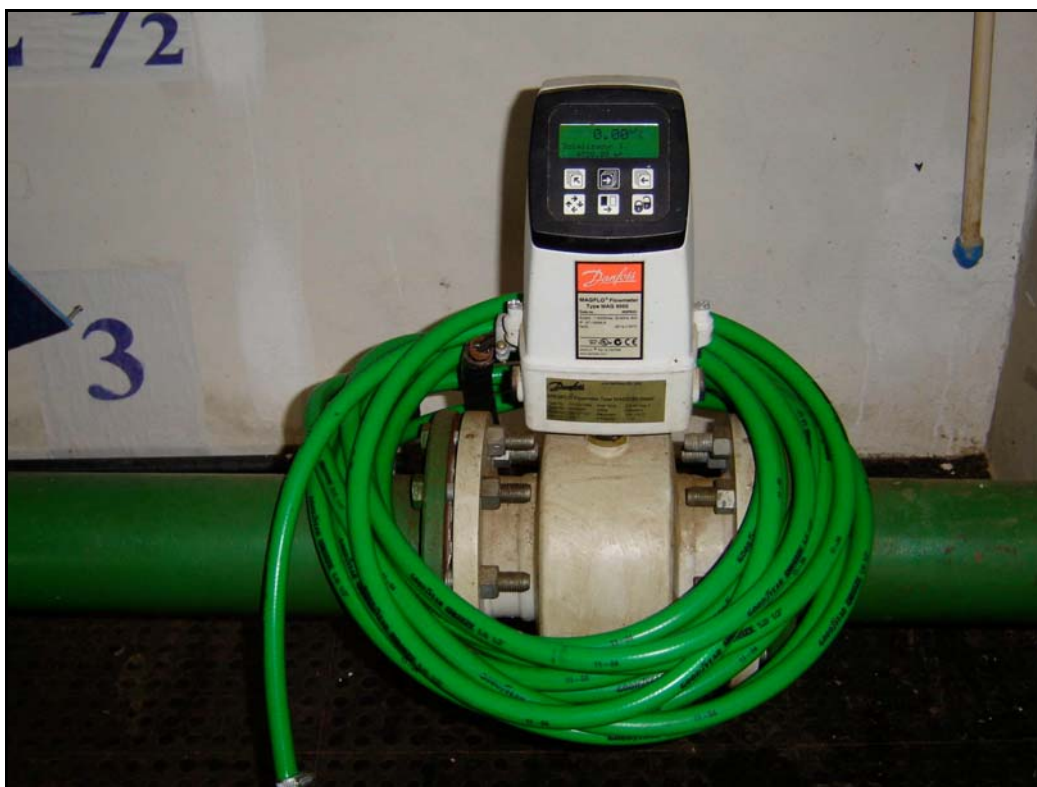
Foto 32 – EE-03 - Medidor de Vazão
