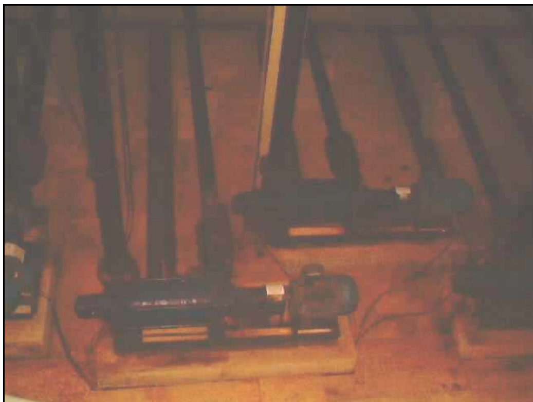
Foto 52 – EE-06 - Conjuntos de Recalque
