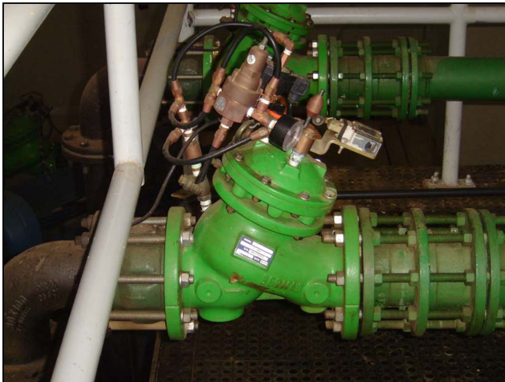
Foto 31 – EE-03 - Barriletes de Recalque para EE-04 - Detalhe para Válvulas Controladoras de Bomba
