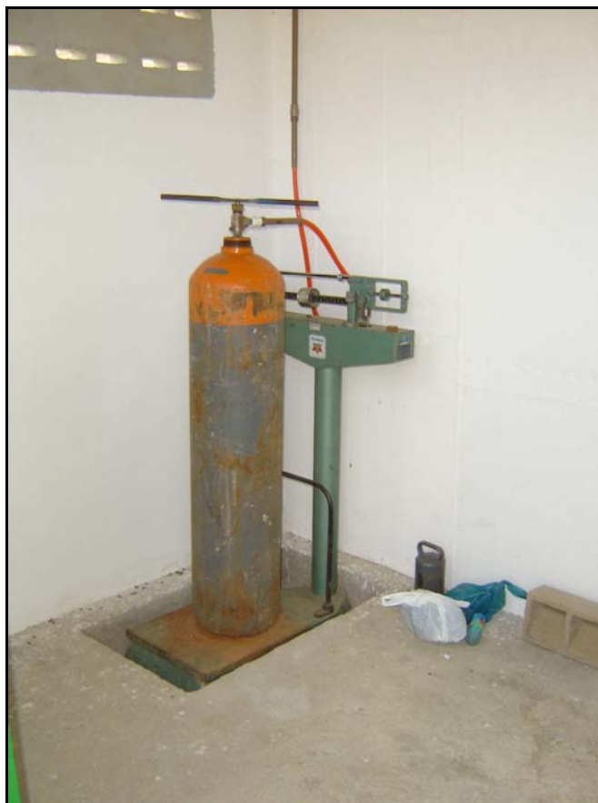
Foto 49 – EE-05 - Equipamentos de Reforço de Cloração
