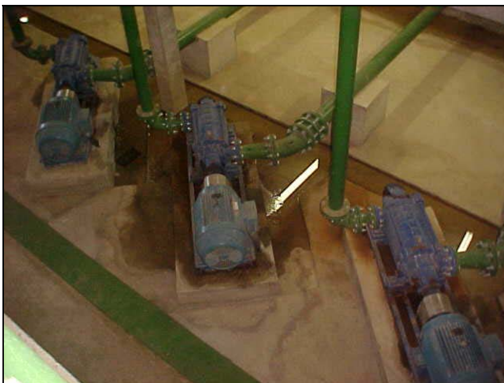
Foto 12 – EB 02 - Conjuntos Elevatórios
