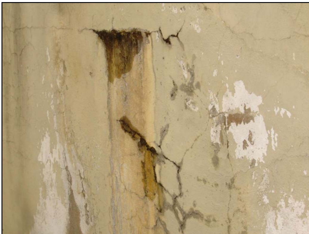
Foto 35 – EE-03 - Detalhe das Fissuras e Infiltração no Reservatório Apoiado
