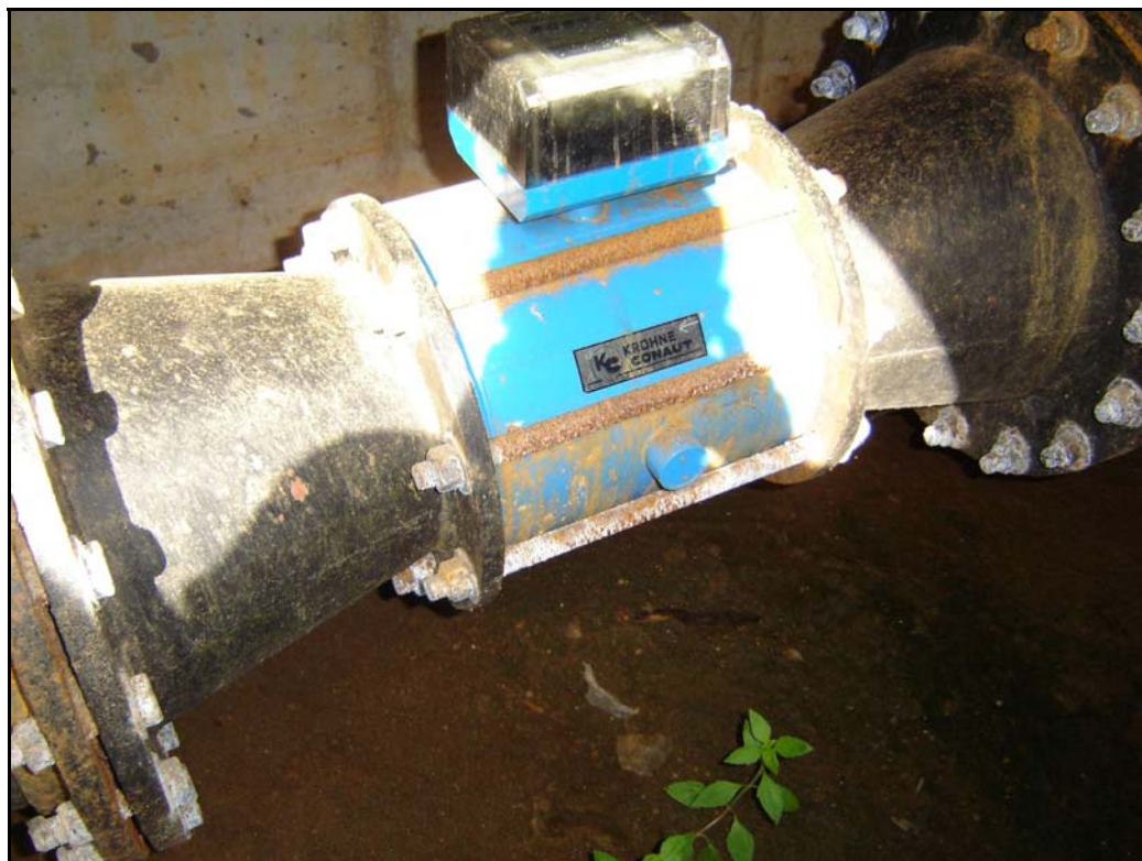
Foto 02 – Medidor de Vazão na Tubulação de Alimentação do Sistema Adutor do Cariri
