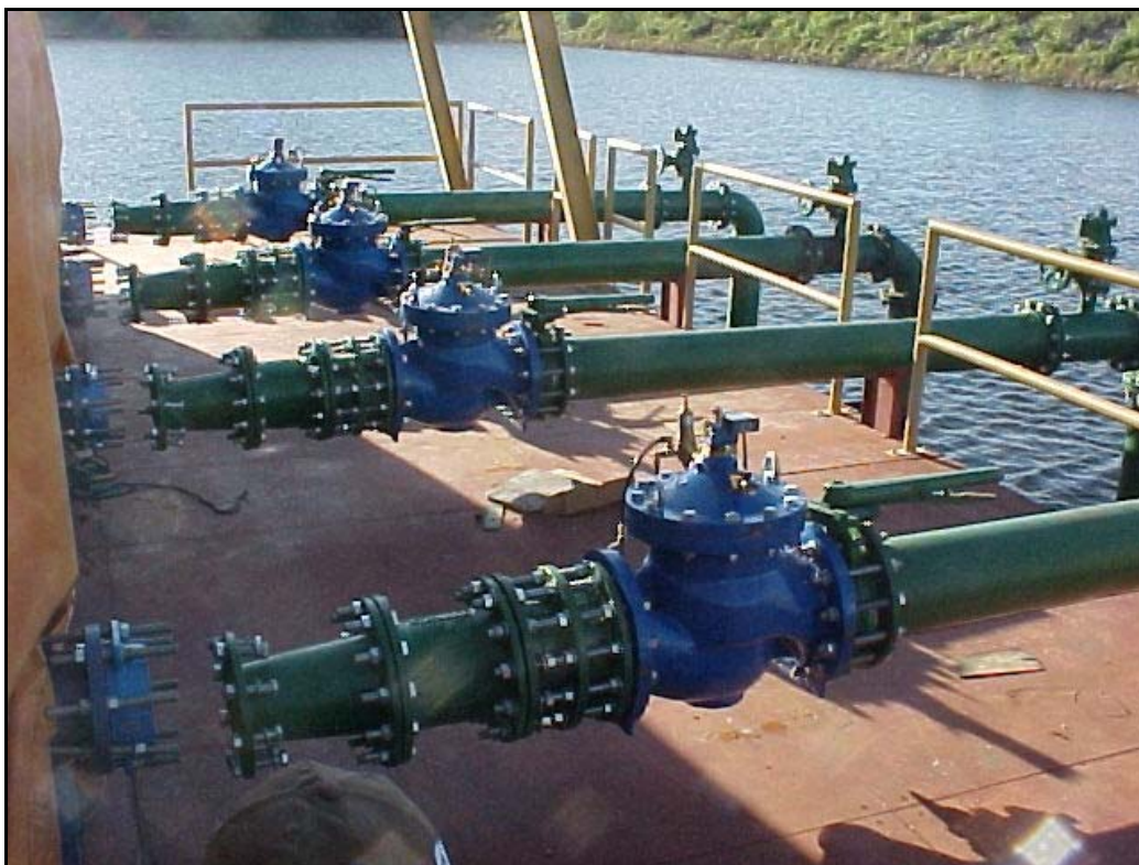
Foto 03 – EB Flutuante - Detalhe das Válvulas
