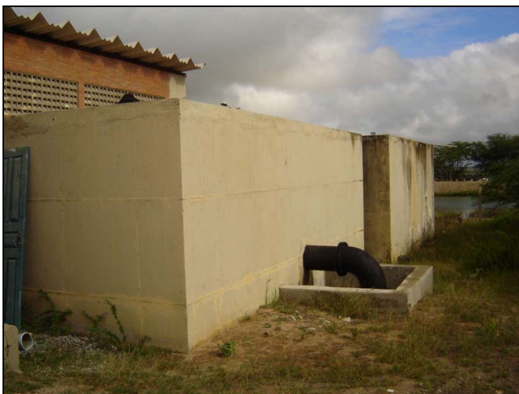
Foto 34 – EE-03 - Tanque de Sucção e Reservatório Apoiado para Rede de Boa Vista
