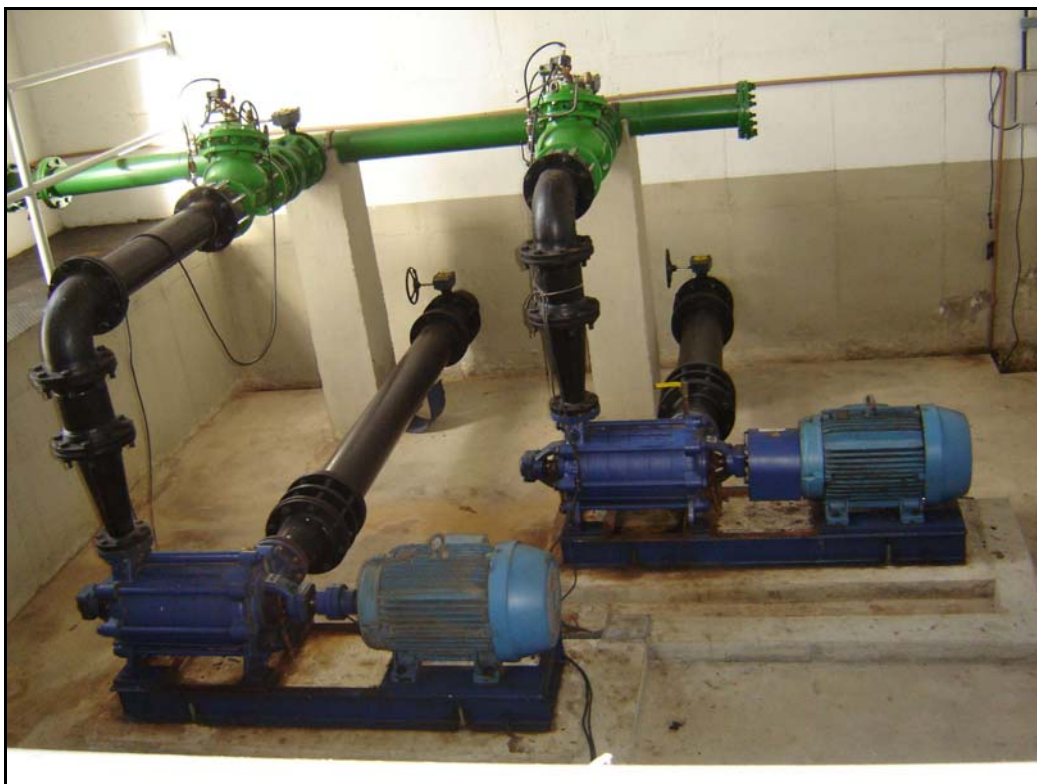
Foto 46 – EE-05 - Conjuntos de Recalque para Juazeirinho com Válvulas Controladoras de Bomba
