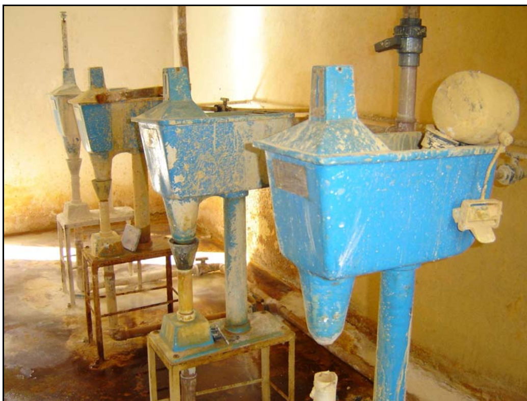
Foto 08 – ETA - Casa de Química - Dosadores de Sulfato
