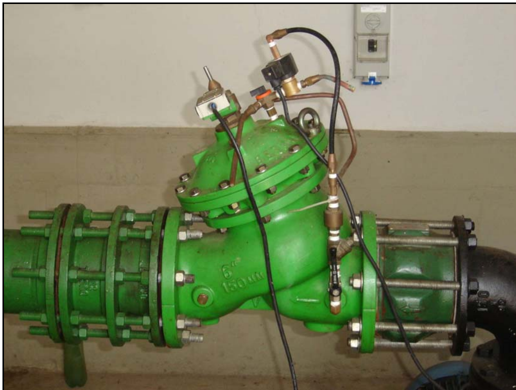
Foto 47 – EE-05 - Detalhe para Válvulas Controladoras de Bomba
