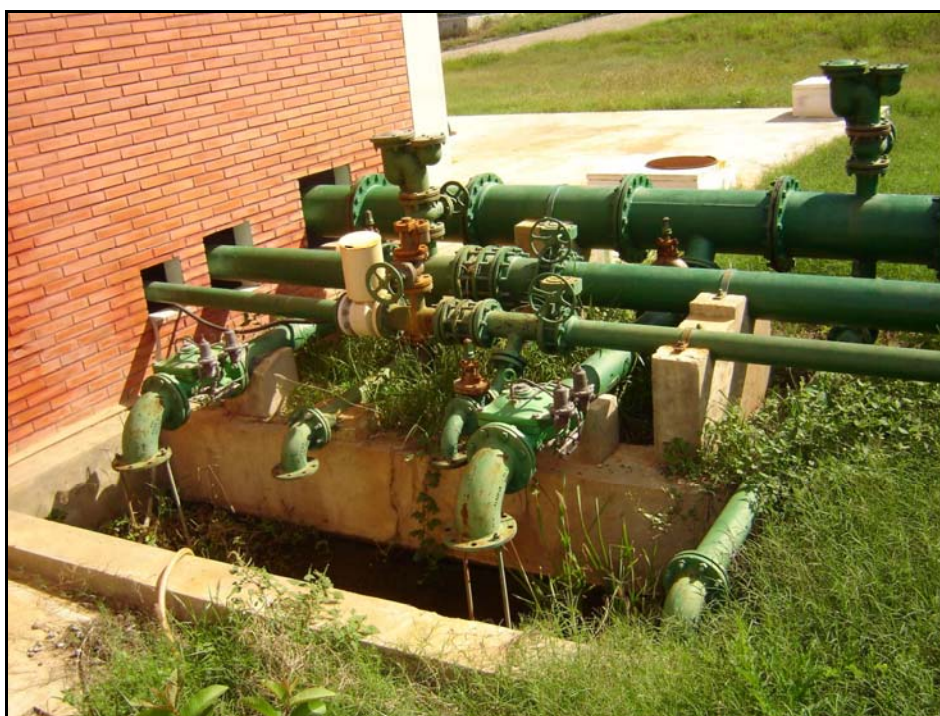
Foto 50 – EE-05 - Barrilete de Recalque - Podendo Observar-se a Conservação Inadequada, com o Crescimento Descontrolado da Vegetação no Local
