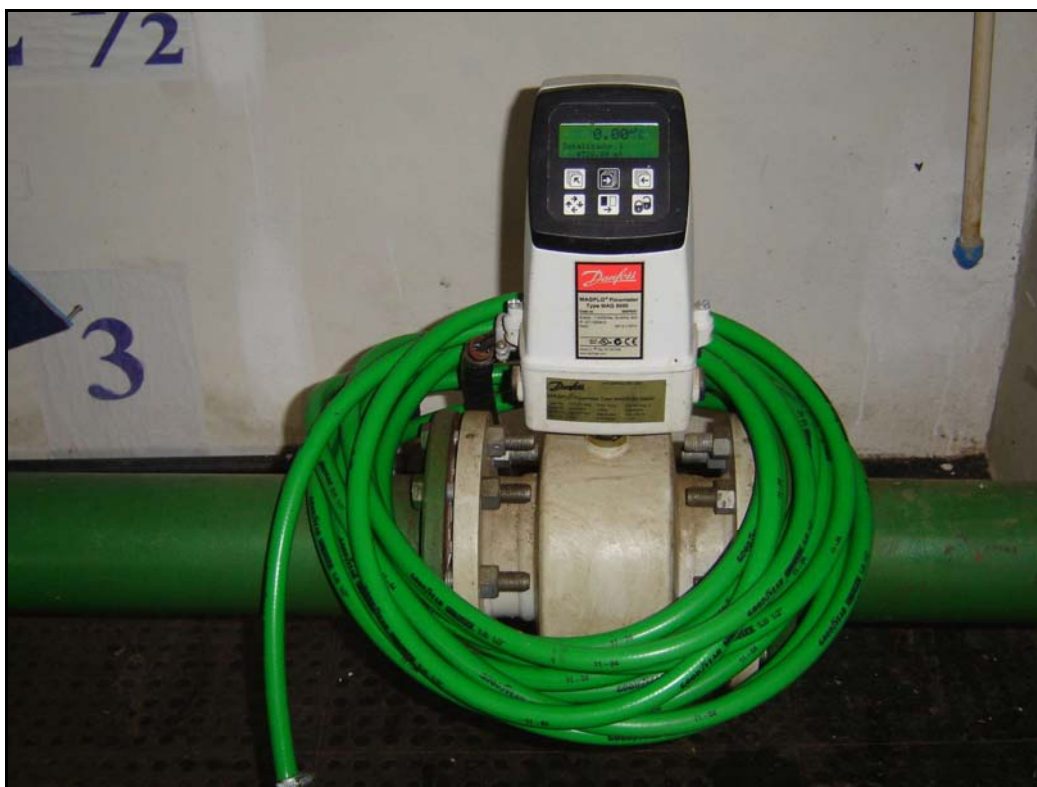
Foto 32 – EE-03 - Medidor de Vazão
