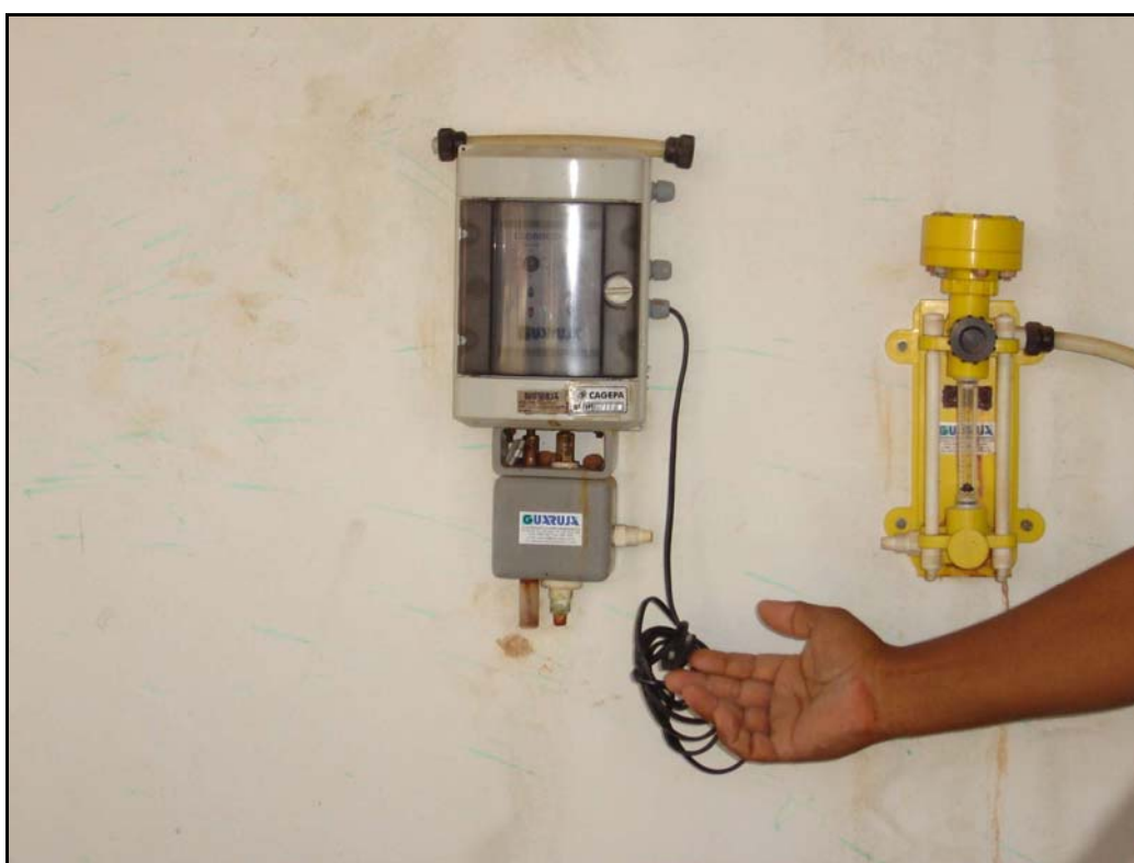
Foto 10 – ETA - Casa de Química - Dosador de Cloro Desligado
