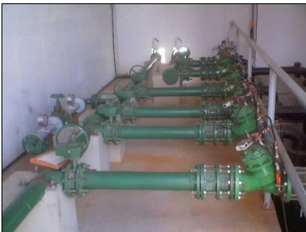
Foto 54 – EE-06 - Barriletes de Recalque com Válvulas Controladoras de Bomba
