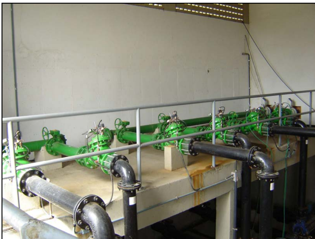
Foto 40 – EE-04 - Barriletes de Recalque com Válvulas Controladoras de Bombas
