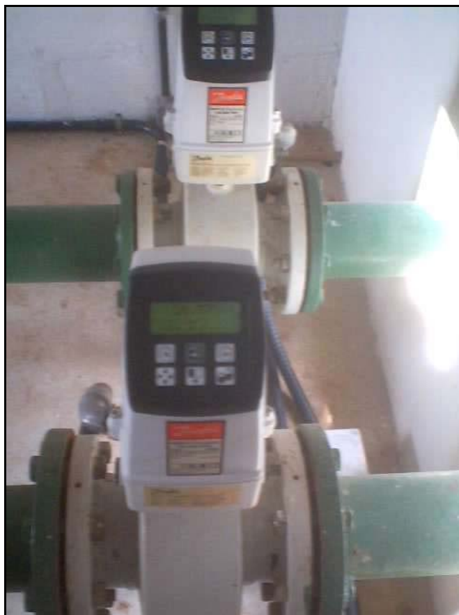
Foto 55 – EE-06 - Detalhes do Medidor de Vazão
