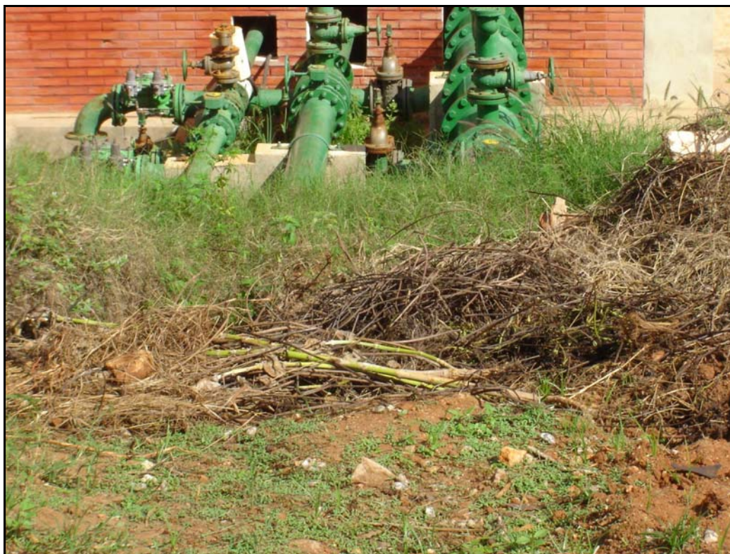
Foto 17 – EE-01 - Caixa de Saída dos Barriletes de Recalque Detalhe para Área Inundável e Condições de Conservação
