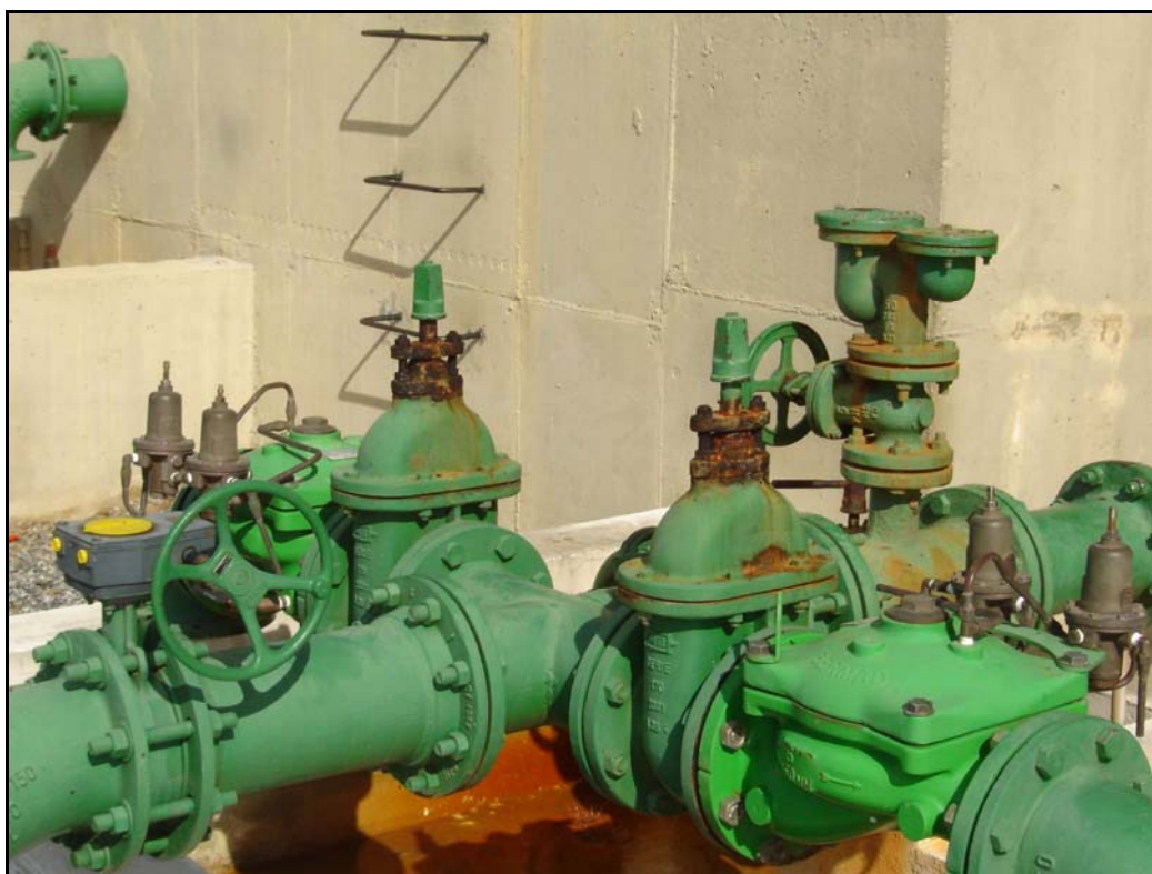
Foto 48 – EE-05 - Caixa de Saída dos Barriletes de Recalque Detalhe para Válvula Antecipadora de Onda e Falta de Manutenção (Oxidação nos Registros)
