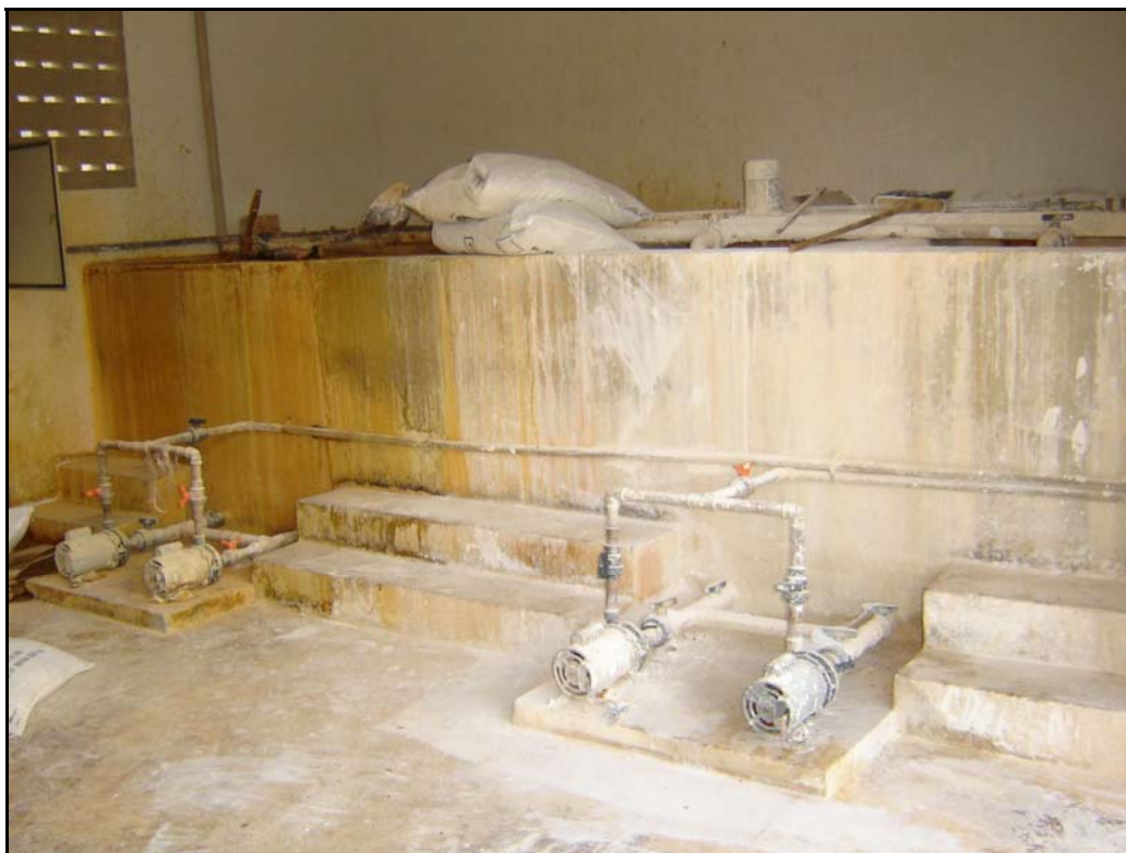
Foto 07 – ETA - Casa de Química - Tanques de Solução de Sulfato e Cal
