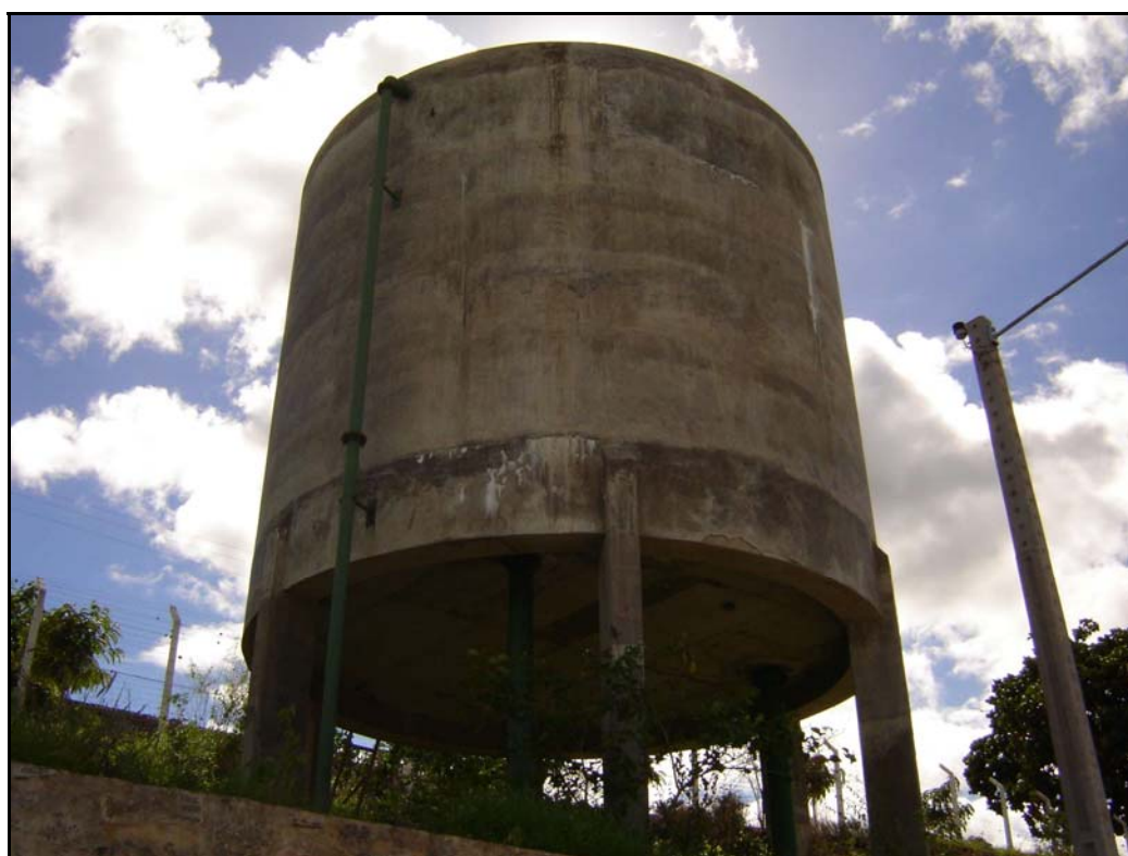
Foto 12 – ETA - Reservatório de Lavagem dos Filtros
