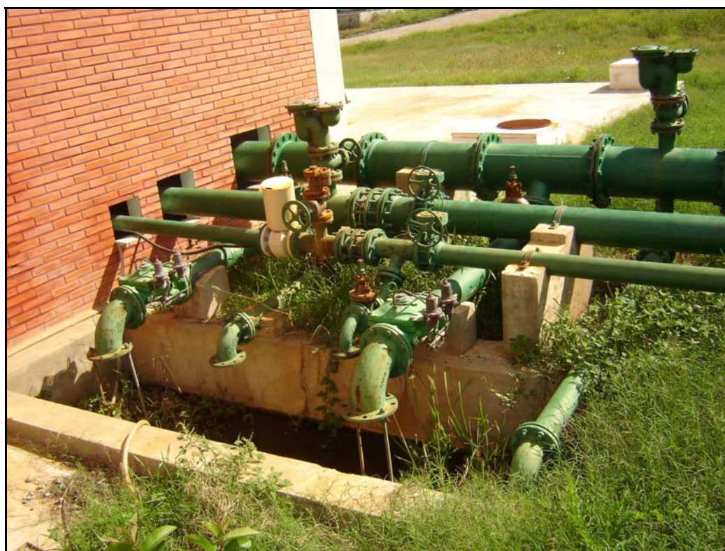
Foto 18 – EE-01 - Caixa de Saída dos Barriletes de Recalque Detalhe para Válvula Antecipadora de Onda
