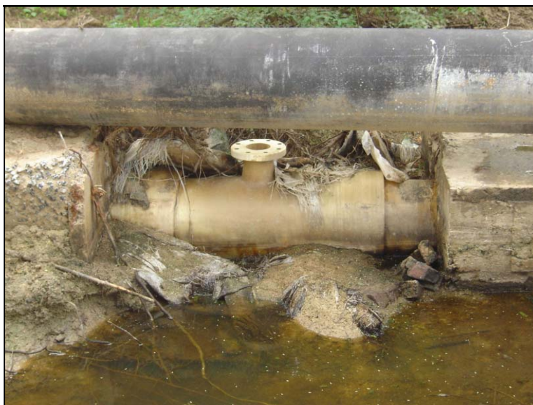
Foto 60 – Travessia Provisória no Riacho Boa Vista Detalhe das Caixas de Descarga e Registro Destruidas
