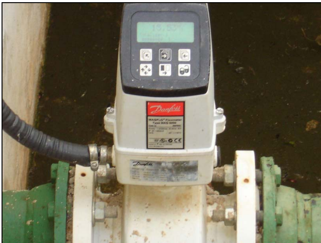
Foto 25 – EE-02 - Detalhe Medidor de Vazão
