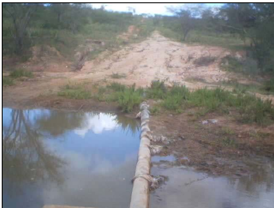
Foto 62 – Travessia Provisória no Riacho Soledade Detalhe dos Sacos de Areia para Proteger e Firmar o Tubo
