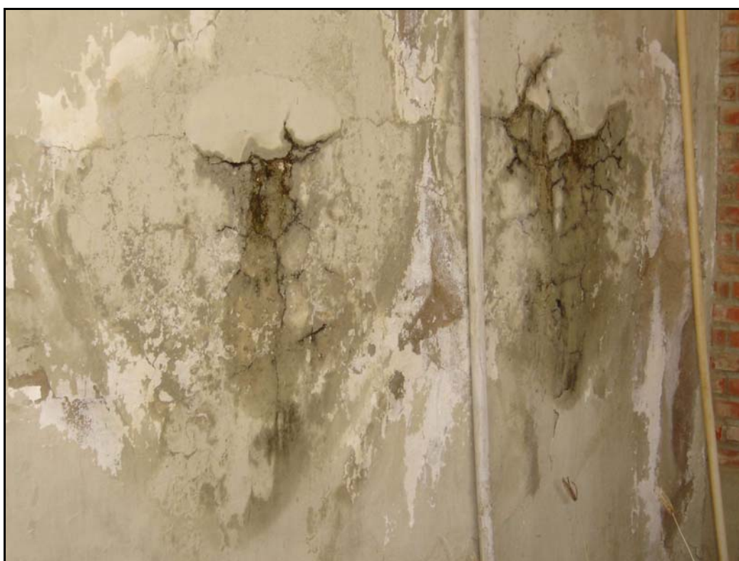
Foto 36 – EE-03 - Detalhe das Fissuras e Infiltração no Reservatório Apoiado
