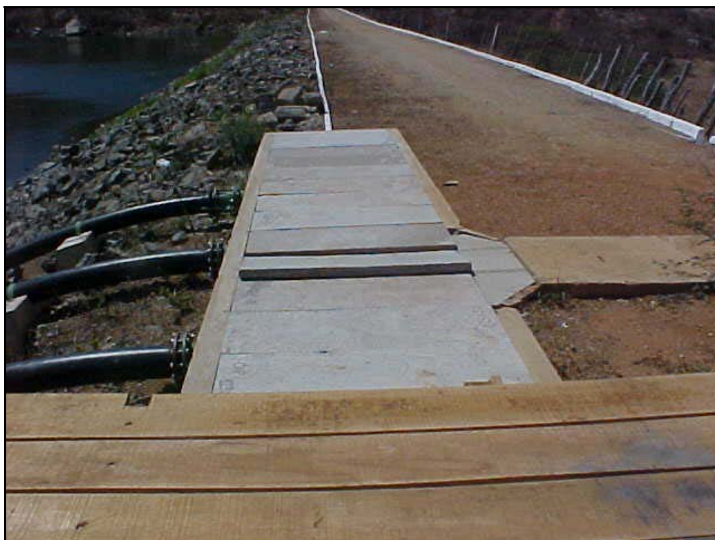
Foto 08 – Caixa de Abrigo do Barrilete de Recalque
