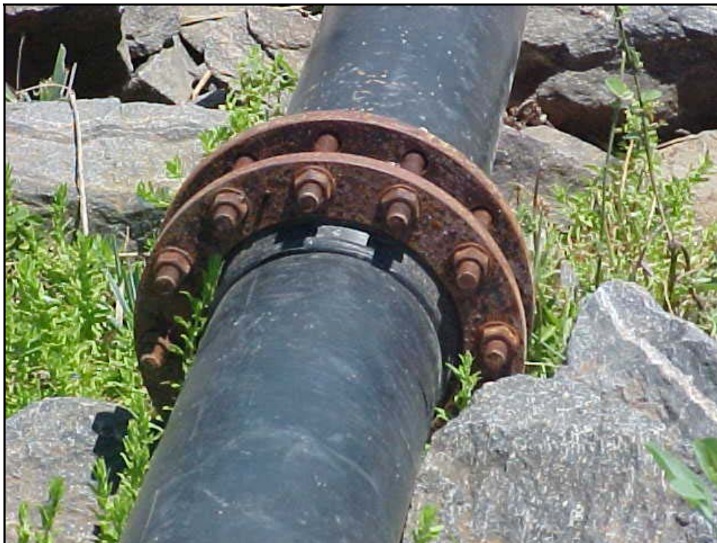
Foto 05 – Tubo PEAD – Detalhe dos Flanges
