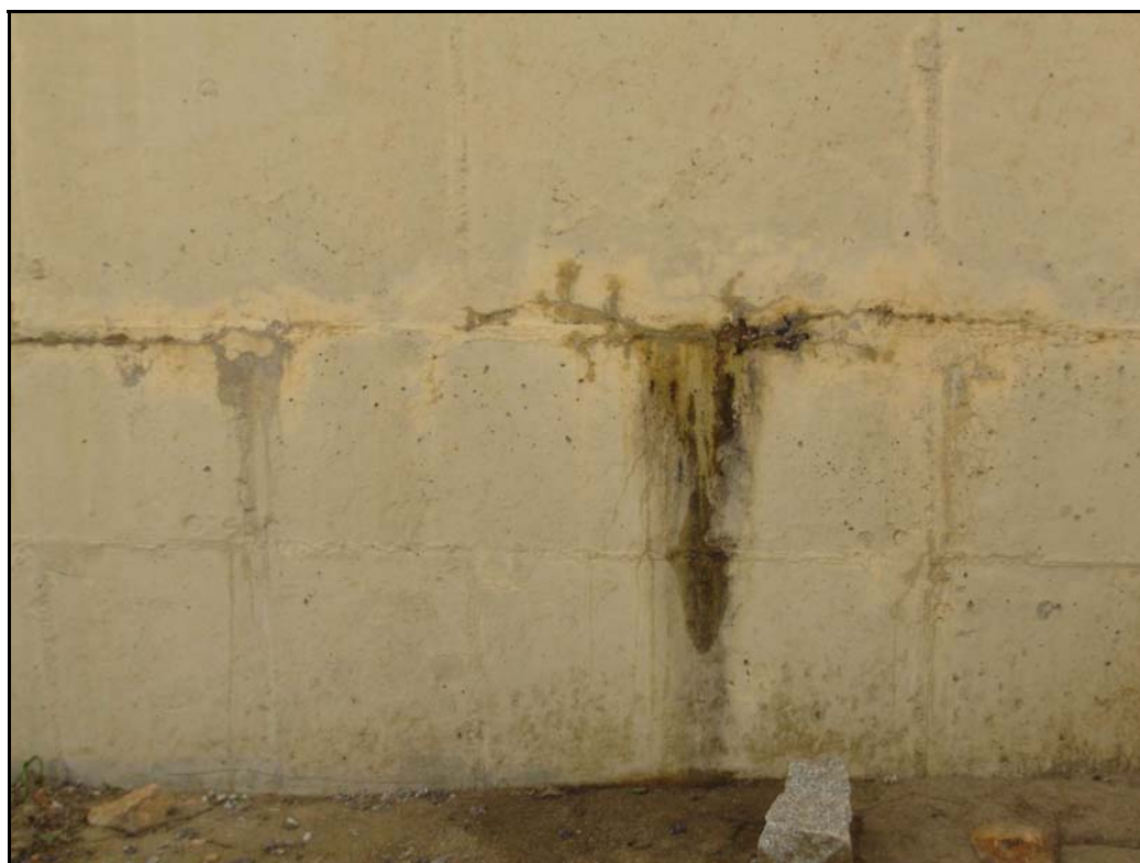
Foto 44 – EE-04 - Fissuras no Tanque de Sucção
