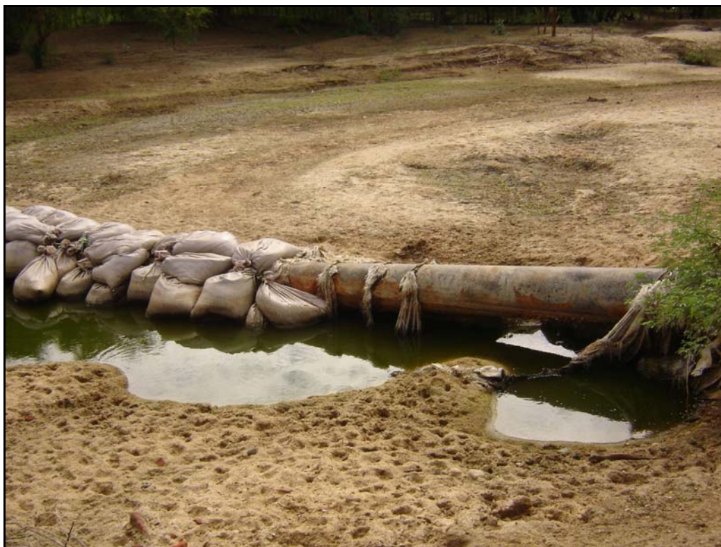
Foto 59 – Travessia Provisória no Riacho Boa Vista Detalhe dos Sacos de Areia para Proteger e Firmar o Tubo
