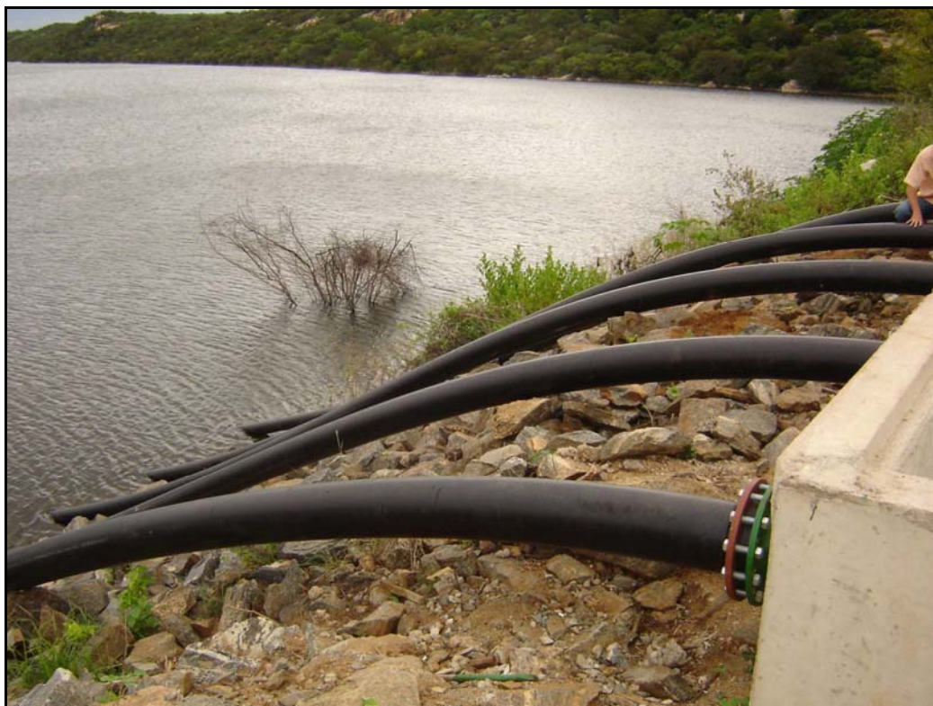
Foto 07 – Barrilete de Recalque da EB Flutuante - Enfatiza a Falta de Registros de Parada
