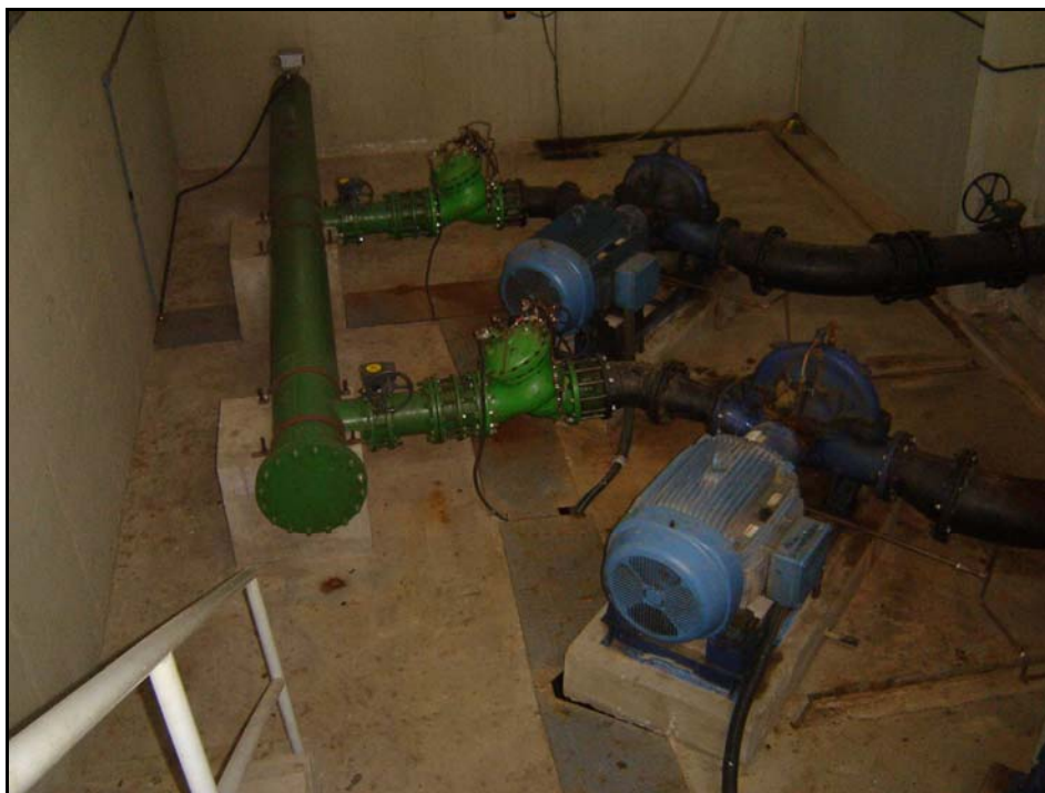
Foto 30 – EE-03 - Conjuntos de Recalque para EE-04 com Válvulas Controladoras de Bomba
