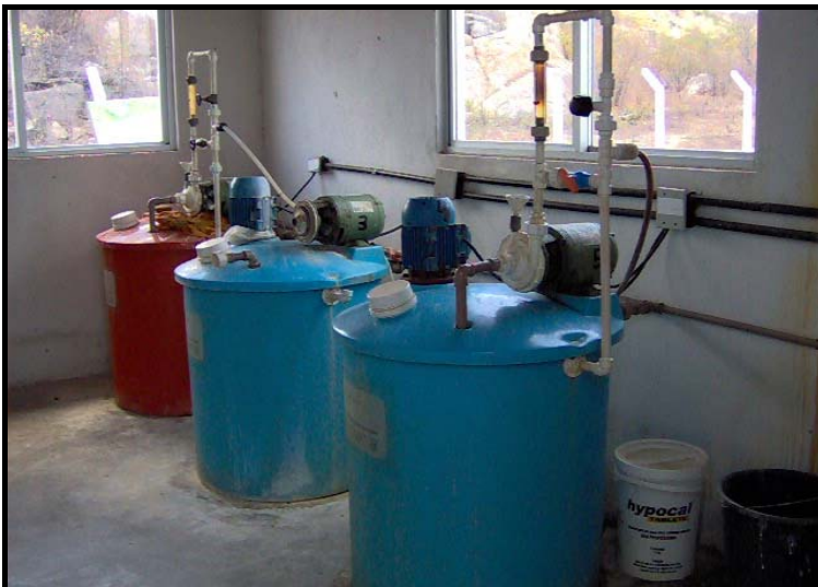
Foto 29 – Vista dos tanques de dosagem da ETA de São Francisco
