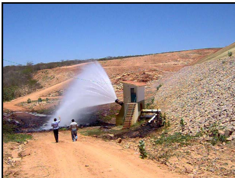
Foto 4 – Vista da válvula dispersora da barragem Capivara
