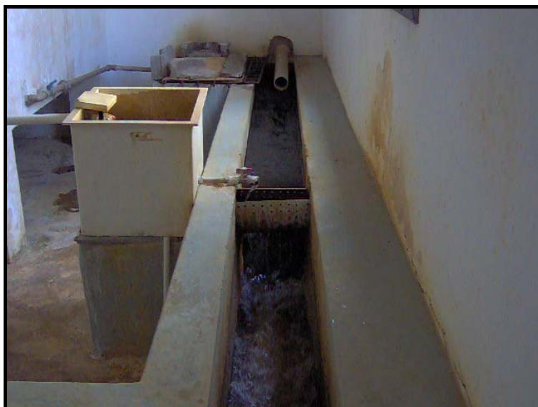
Foto 10 – Vista da calha Parshall da ETA de Uiraúna
