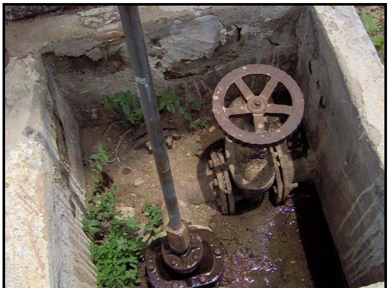
Foto 18 – Vista dos registros do reservatório de Lastro
