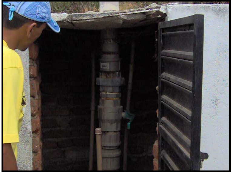
Foto 16 – Vista da tubulação do mesmo poço (instalação abrigada)
