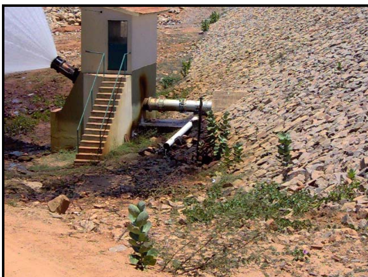
Foto 5 – Vista da válvula de descarga da barragem Capivara
