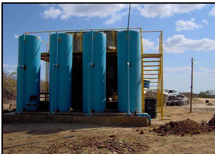
Foto 20 – Vista parcial do decantador da ETA da cidade de Santa Cruz
