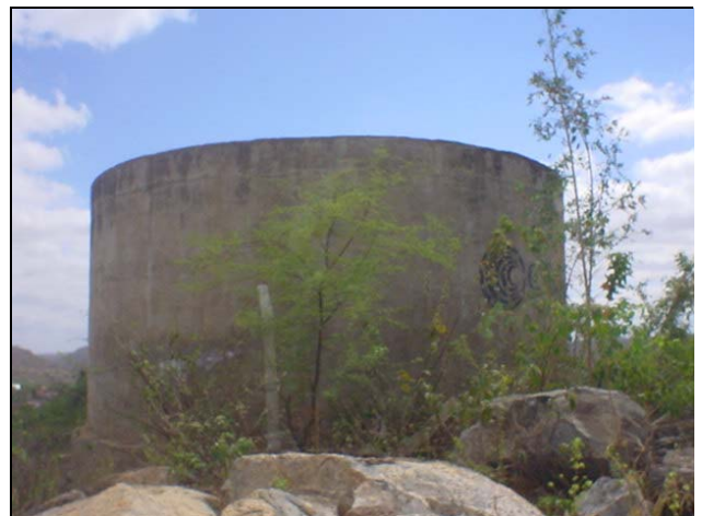
Foto 3.16 – Reservatório de Distribuição Apoiado (100m 3 ) – Visão Aproximada
