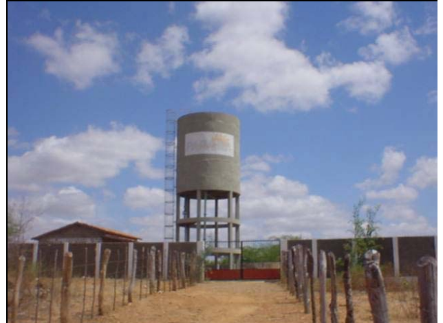
Foto 3.11 – Reservatório Elevado de 100m³
