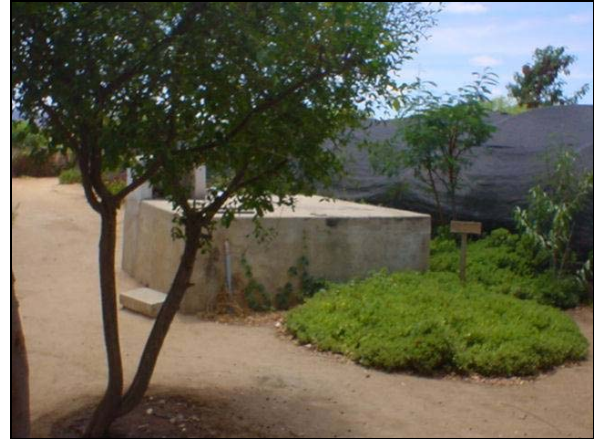
Foto 2 – Reservatório enterrado junto do dessalinizador de São João do Tigre
