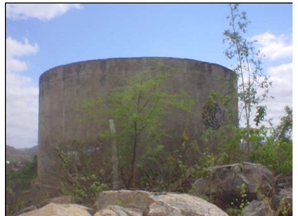
Foto 16 – Reservatório de distribuição apoiado (100m³) – Município de Camalaú.
