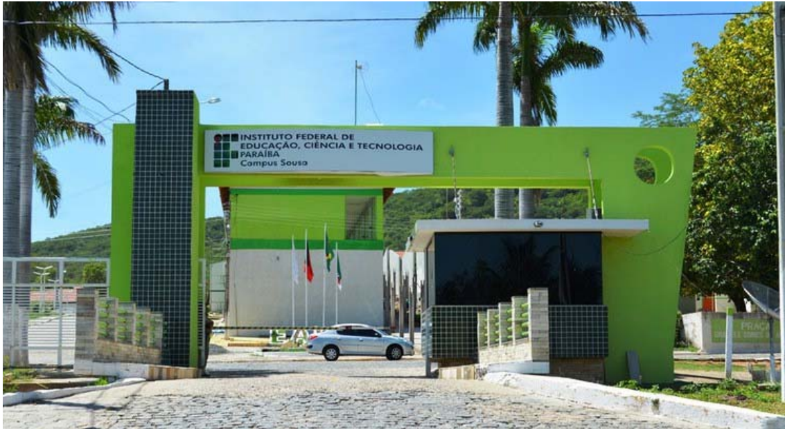
Figura 3.74 – Instituto Federal da Paraíba – Campus Sousa
