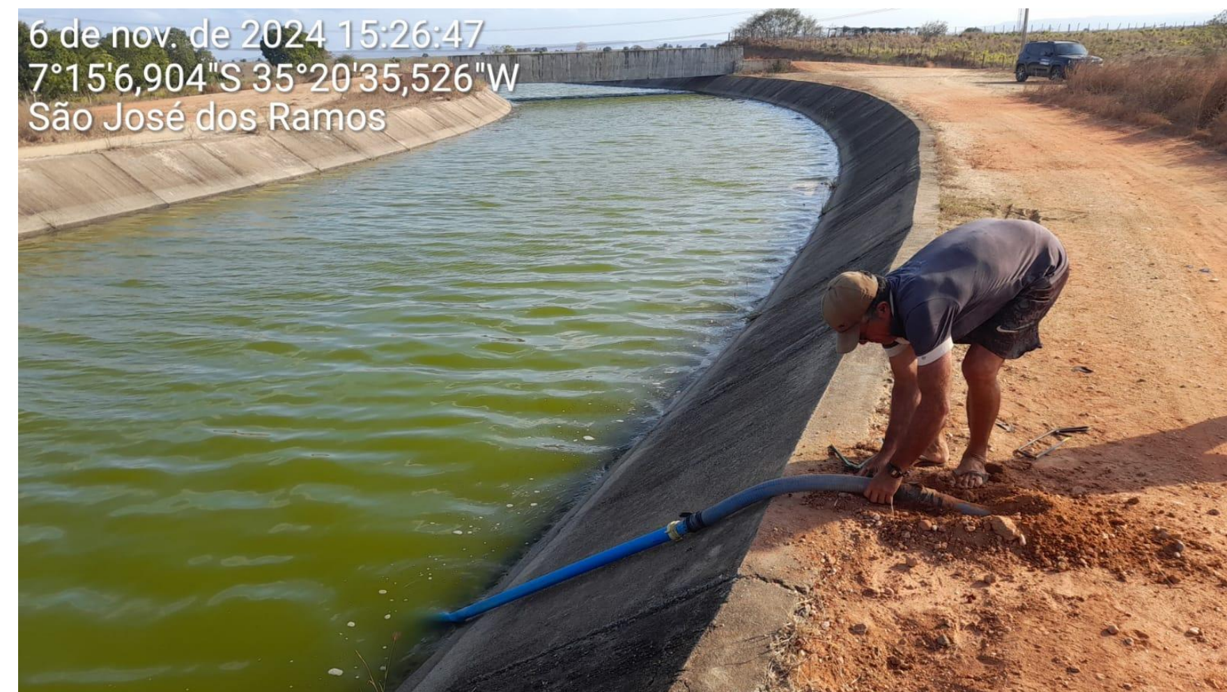
REMOÇÃO DE SIFÃO IRREGULAR NO CANAL DAS VERTENTES LITORÂNEAS
