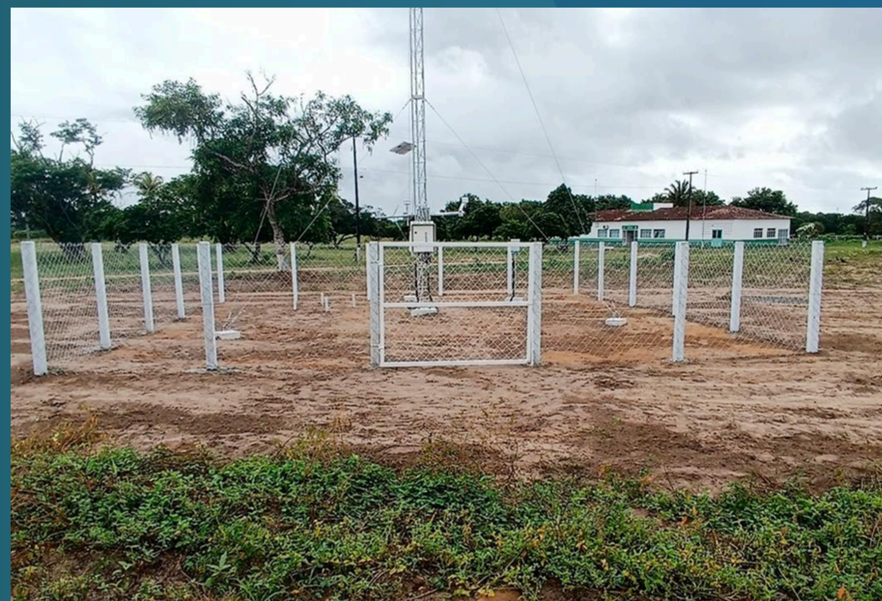
ESTAÇÃO AGROMETEOROLÓGICA INSTALADA MAMANGUAPE
