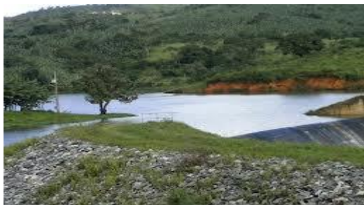
Barragem de Natuba
