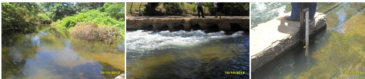
Visita ao Rio Piranhas entre a Barragem de Eng o Ávidos e Açude São Gonçalo
