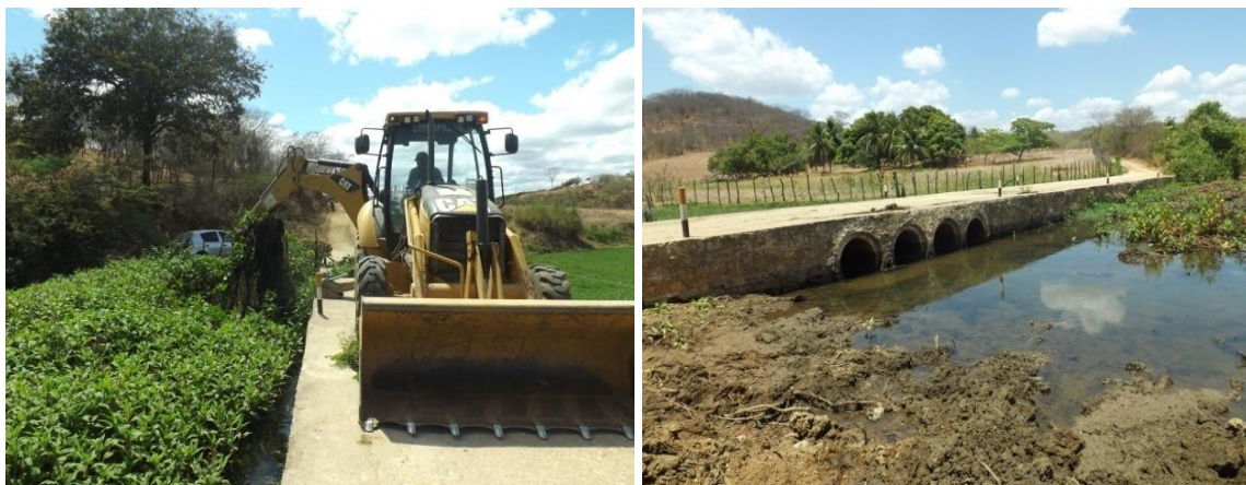
Figura 1: Excesso de vegetação a montante da passagem molhada localizada na Comunidade Boa Vista. (A) antes da limpeza, (B) após a limpeza.
