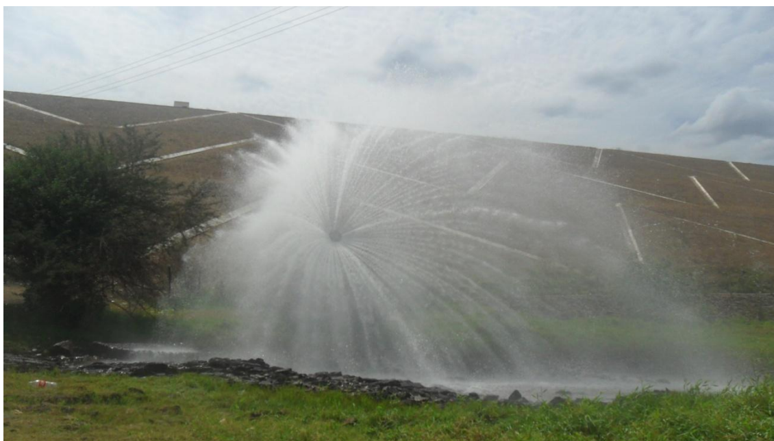
Figura 1: Acompanhamento dos trabalhos de desobstrução do rio Bruscas, em Curral Velho - PB.
