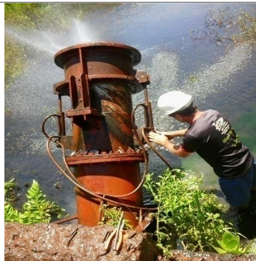
Figura 2. Abertura e desobstrução da comporta da barragem Saco em Nova Olinda – PB Fonte: Araujo, V. L. (Setembro de 2014)
