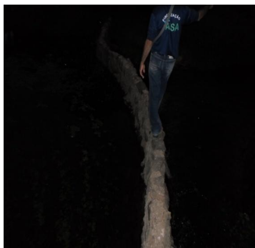
Figura 4. Barramento no leito do Rio Vazante, através de parede de alvenaria, em ângulo vertical. Fonte: A. O. Malta (julho de 2014)
