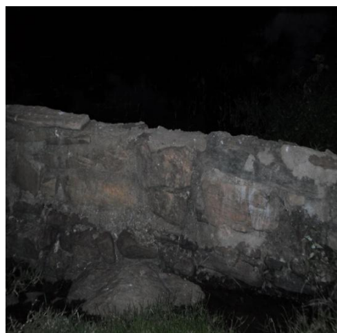
Figura 5. Barramento no leito do Rio Vazante, através de parede de alvenaria, em ângulo horizontal. Fonte: A. O. Malta (julho de 2014)
