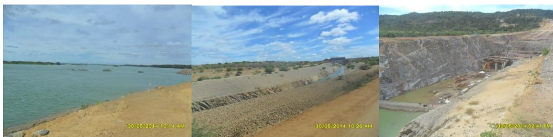
Obras da integração do rio São Francisco
