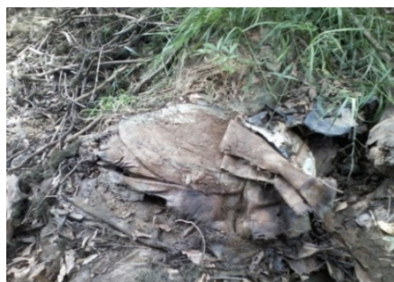
Barramento construído com sacos de areia.
