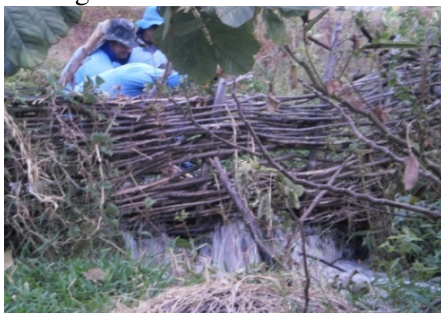
Cerca de varas impedindo o fluxo da água no leito do rio.
