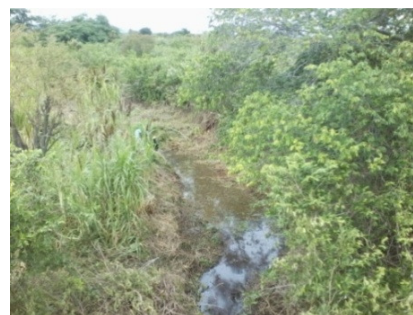
Trecho com limpeza realizada pela CAGEPA
