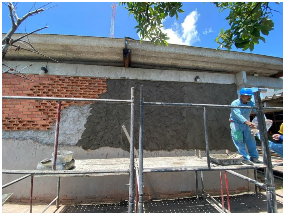
Figura 152 - Fachada em obra
