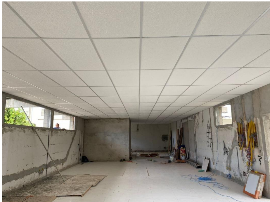
Figura 150 – Instalações elétricas, forro e início da fase de acabamento
