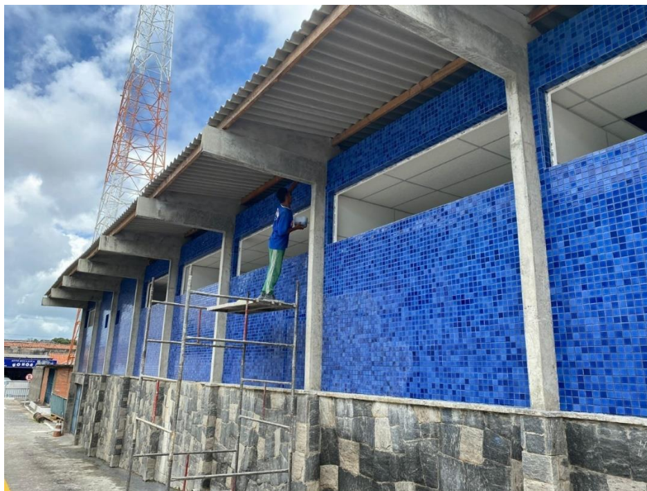
Figura 153 - Revestimento da fachada
