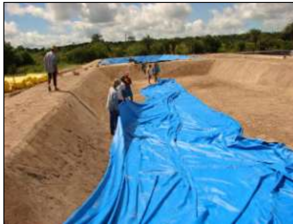
Foto 58 Processo de aplicação da geomembrana (passo 2)
