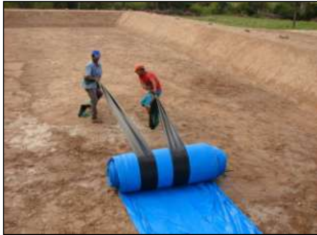
Foto 57 Processo de aplicação da geomembrana (passo 1)
