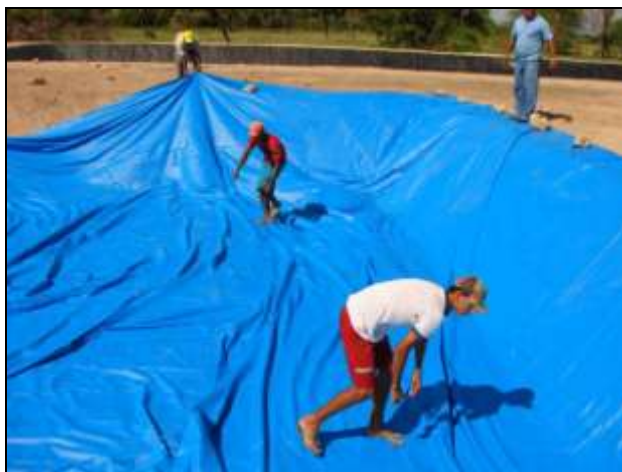
Foto 59 Processo de aplicação da geomembrana (passo 3)
