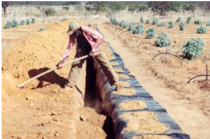
Foto 56 Septo impermeável colocado ao redor da área a ser cultivada.
