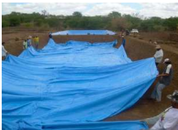
Foto 18 UD de Amparo/PB. Impermeabilização dos viveiros
