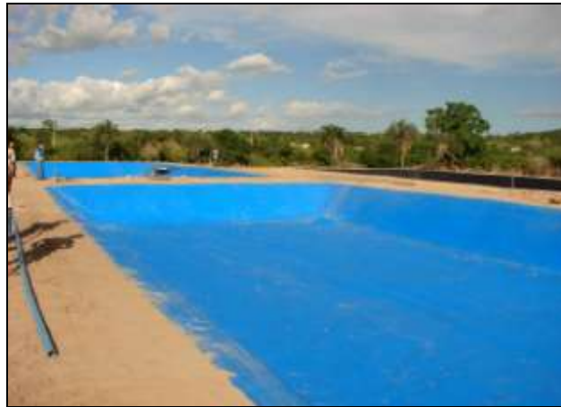
Foto 62 Fixação da geomembrana na vala de ancoragem
