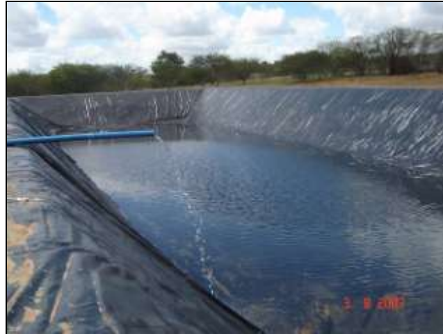
Foto 63 Abastecimento de água
