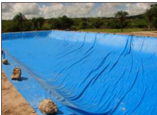
Foto 61 Lastreamento da geomembrana na vala de ancoragem
