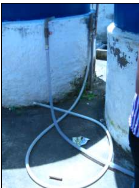
Foto 40 Mangueiras utilizadas na distribuição de água dispostas de maneira inadequada
