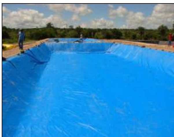
Foto 60 Processo de aplicação da geomembrana (passo 4)
