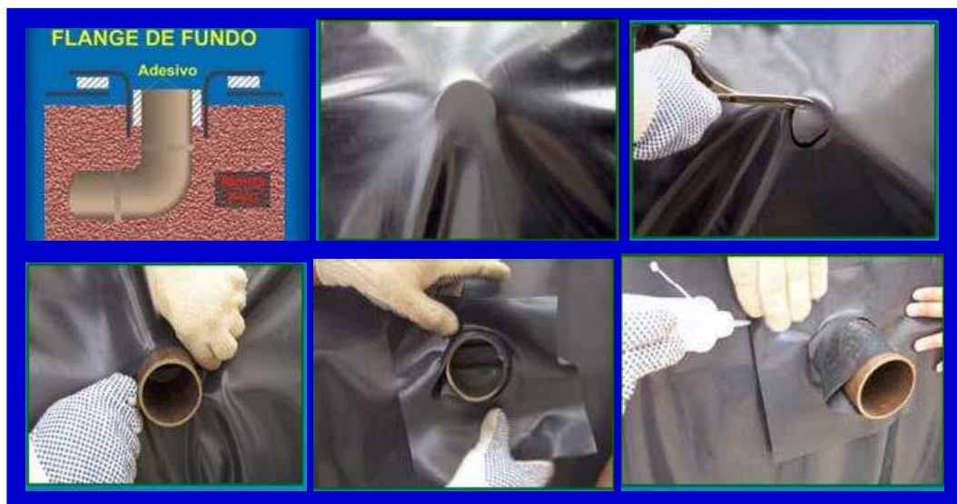
Figura 47 Sequencia da colocação do flange de fundo do viveiro
