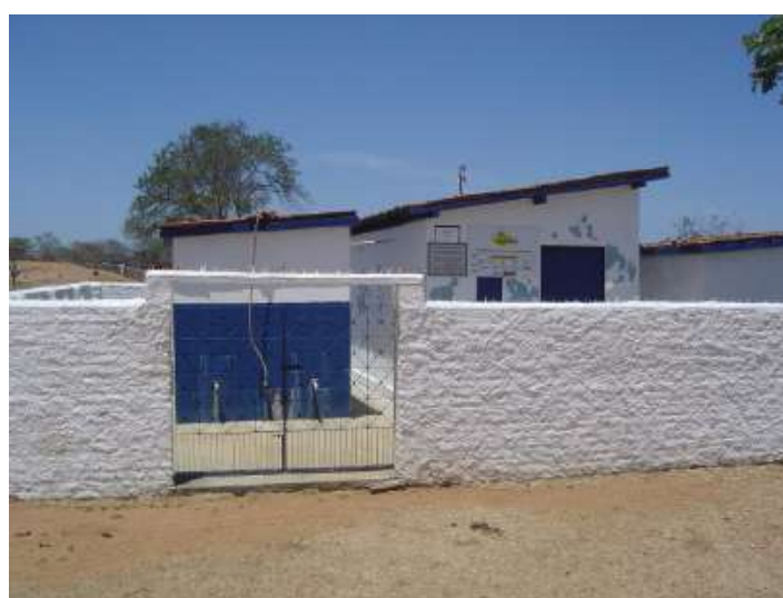
Foto 35 Sistema de dessalinização em Serra Branca/PB
