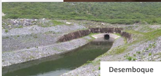
Túnel Cuncas I
