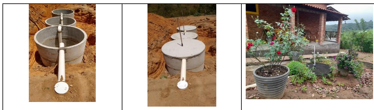
Figura 1 - Fossa séptica biodigestora em construção e implementada
