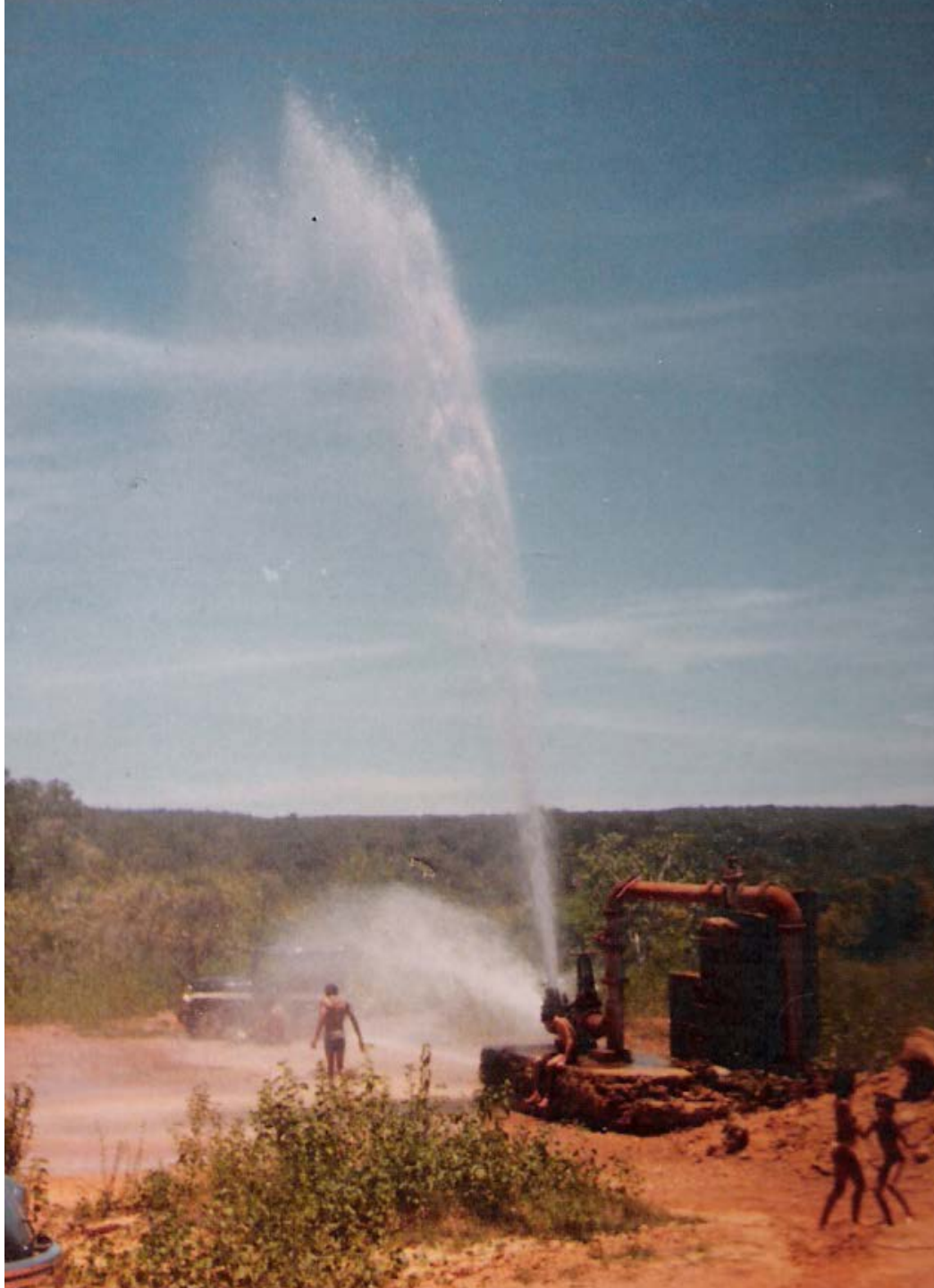
Poço Santa Fé
