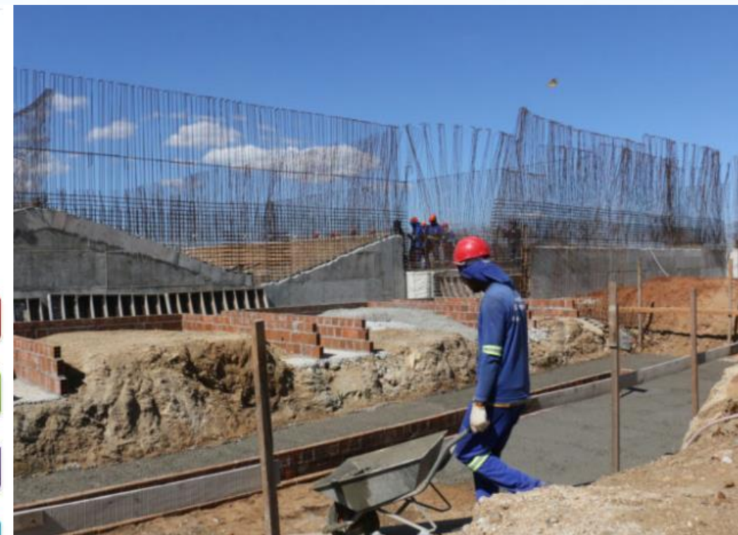
1ª etapa das obras do sistema adutor TransParaíba Ramal Curimataú em Boqueirão
