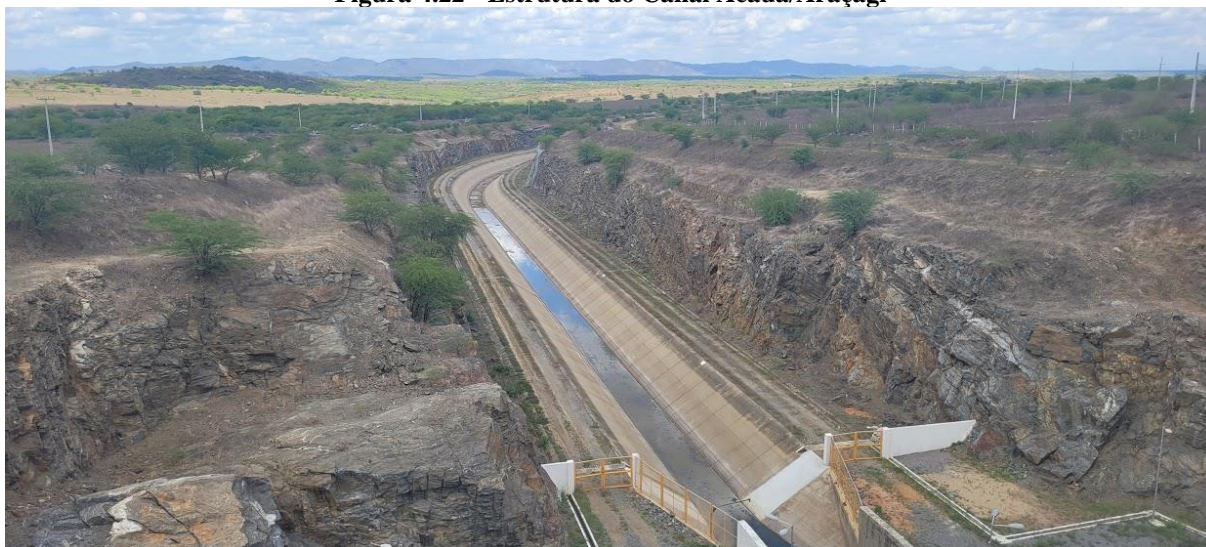
Figura 4.22 - Estrutura do Canal Acauã/Araçagi
